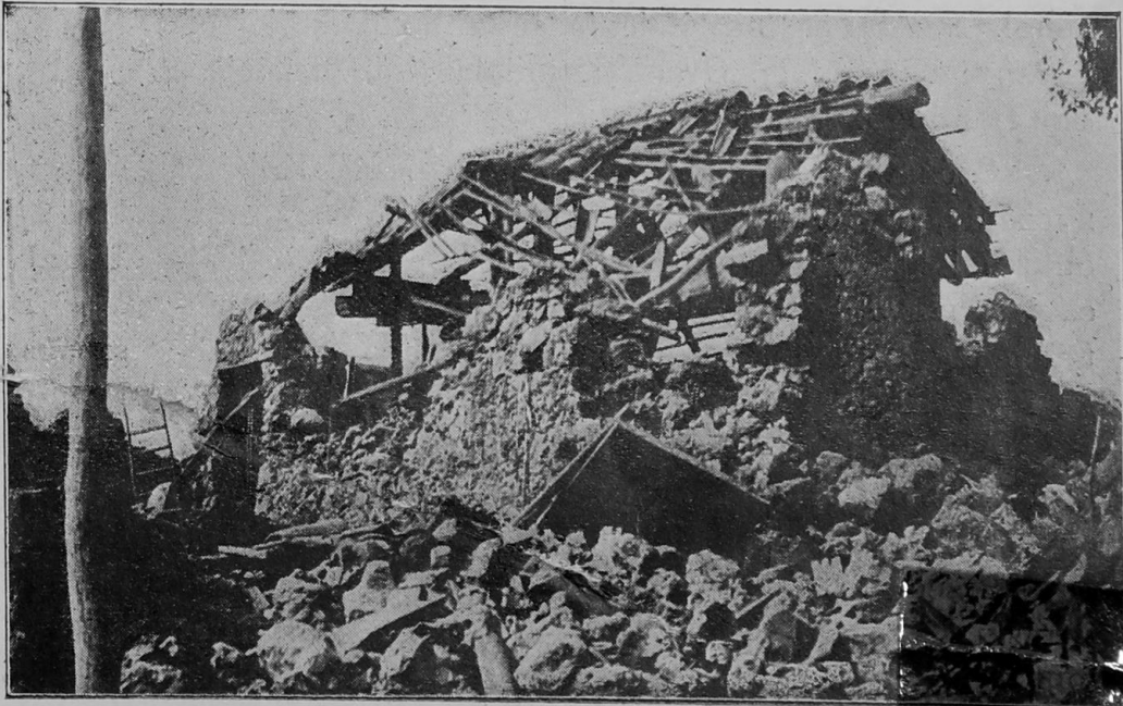
Dom zrujnowany przez trzęsienie ziemi w Sycylii.
