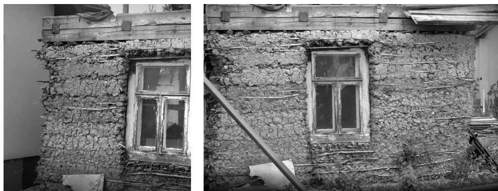
Ryc. 3.22. Ruiny domu glinojąłowcowego (glinobito-zbrojonego) w Zalesiu w gminie Wyszki; fot. autor, 2008
