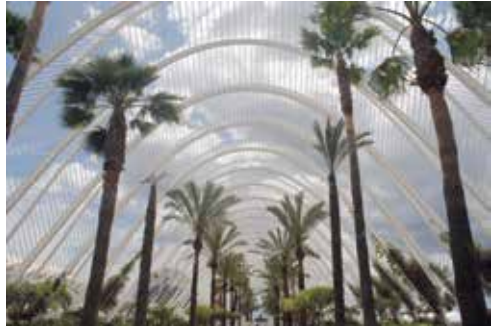
Fig. 1.24. Umbracle in Ciudad de las Artes y las ciencias Valencia (Valencia, Spain) (Source: photos by M. Kłopotowski)
