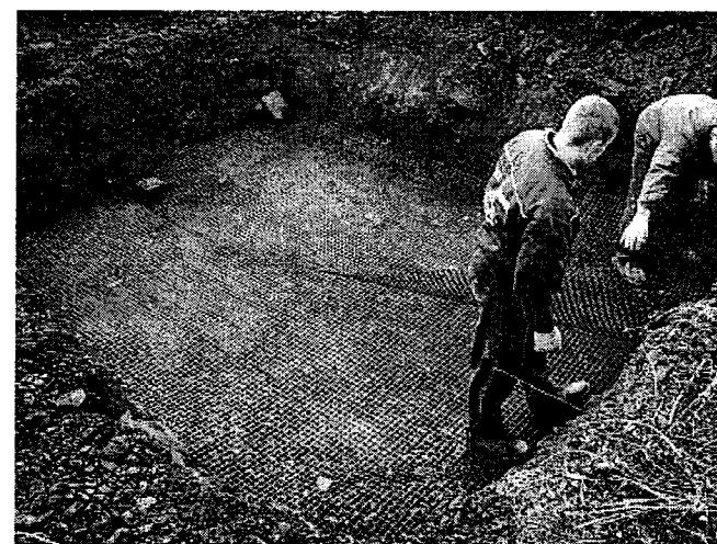
Rys. 3. Układanie pierwszej warstwy geokraty
