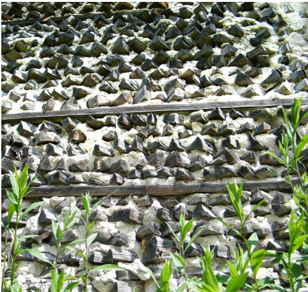
Ryc. 86. Fragment drewnobetonowej ściany domu w Kamieńskim w gm. Cerańów; fot. autor, 2010
