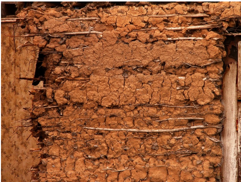
Ryc. 50. Ściana glinobita gęsto zbrojona chrustem jałowcowym (wieś Zalesie w gminie Wyszki na Białostocczyźnie); fot. autor, 2008
