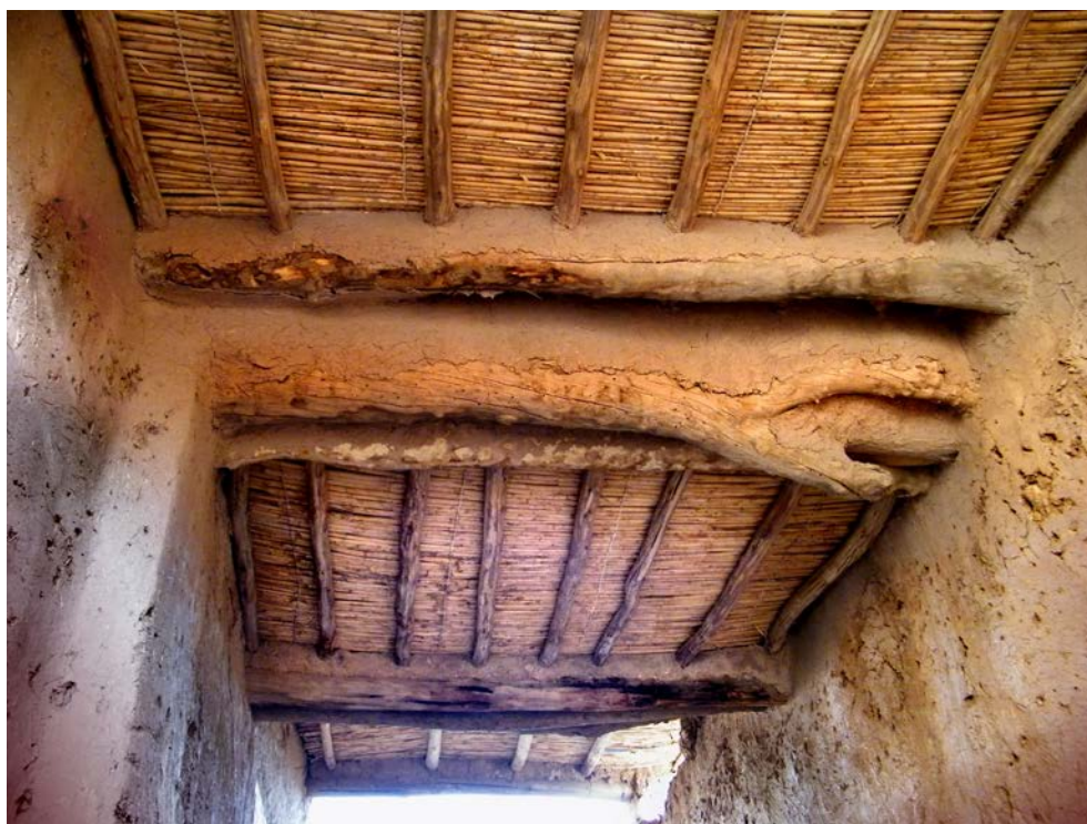
Ryc. 8. Trzcinowe maty nakrywające strop korytarza pustynnego ksaru w marokańskim Ait Ben Haddou, będące tam również zbrojeniem stropów międzykondygnacyjnych; fot. autor, 2010
