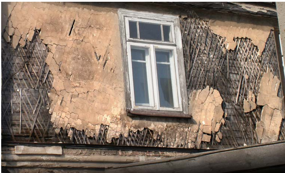
Ryc. 45. Drewniane listwowanie podtynekowe nałożone na warstwę poziomego szalowania zrębowej ściany budynku w centrum Białegostoku; fot. autor, 2006
