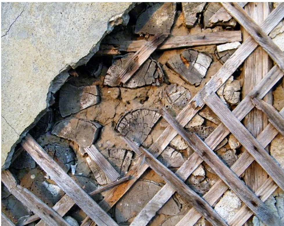
Ryc. 49. Drewniane listwowanie ściany szkieletowo-glinopolanowej; fot. autor, 2010
