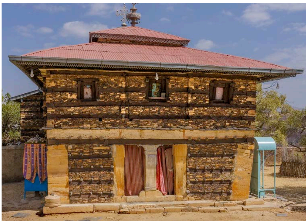
Ryc. 18. Pochodzący z VI wieku n.e. kościół przyklasztorny (należący do Etiopskiego Kościoła Ortodoksyjnego) na górze Debre Damo w regionie Tigray w północnej Etiopii, o ścianach z kamienia wiązane drewnem; źródło: Wikimedia Commons ( https://commons.wikimedia.org/wiki/File:ET_Tigray_asv2018-01_img12_Debre_Damo_Monastery.jpg ), licencja: Free Art License, fot. Alexander Savin, 2018)
