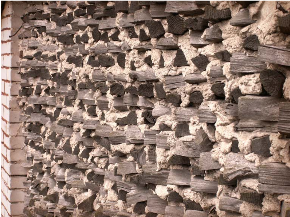
Ryc. 83. Drewnobetonowa szopa w Mężeninie Kolonii; fot. autor, 2008
