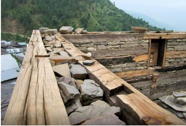
Ryc. 26. Ściana typu kath-khuni ; źródło: Sahapedia ( www.sahapedia.org ), na licencji CC-BY-NC-SA 4.0, fot. Mansi Shah i Jay Thakkar)
