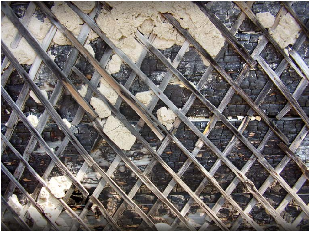
Ryc. 44. Drewniane listwowanie zrębowej ściany stanowiące „zbrojenie” tynku przeciwpożarowego i zapewniające mu przyczepność do elewacji; fot. studenci WA PB (z archiwum Wydziału, 2006)
