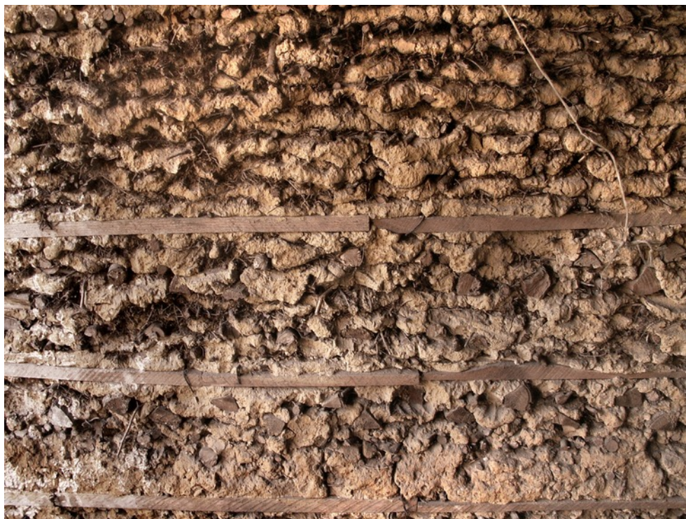
Ryc. 88. Chruścianogliniana ściana budynku gospodarczego w Ogrodnikach koło Siemiatycz, dodatkowo wzmacniana drewnianymi listwami; fot. autor, 2007
