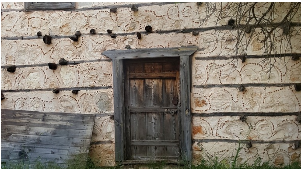
Ryc. 25. Kamienna ściana tureckiego domu zbrojona drewnem; źródło: Wikimedia Commons ( https://en.wikipedia.org/wiki/Sar%C4%B1hac%C4%B1lar,_Akseki#/media/File:Sarihacilar4.jpg ; na licencji CC-BY-SA-4.0, fragment fotografii autorstwa użytkownika Basak, 2017)
