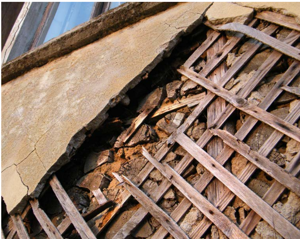
Ryc. 48. Drewniane listwowanie ściany szkieletowo-glinopolanowej; fot. autor, 2010
