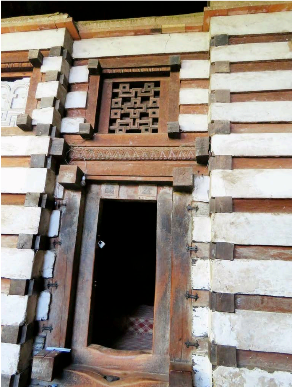
Ryc. 20. Pochodzący z XI wieku n.e. kościół Yemrehana Krestos w północnej Etiopii o ścianach z kamienia gęsto przekładanego drewnem; źródło: Wikimedia Commons ( https://commons.wikimedia.org/wiki/File:Yemrehanna_Kristos_23_(27885838204).jpg ), licencja CC-BY-2.0, fot. Chuck Moravec, 2016)
