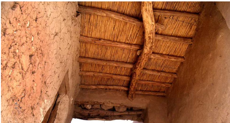
Ryc. 9. Trzcinowy strop pustynnego ksaru w Ait Ben Haddou; fot. autor, 2010
