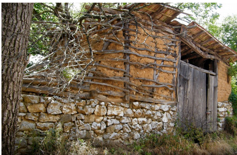
Ryc. 38 i 39. Przykłady konstrukcji bondruk : drewniano-gliniane budynki gospodarcze we wsi Rautovo niedaleko miasta Nisz; fot. autor, 2016
