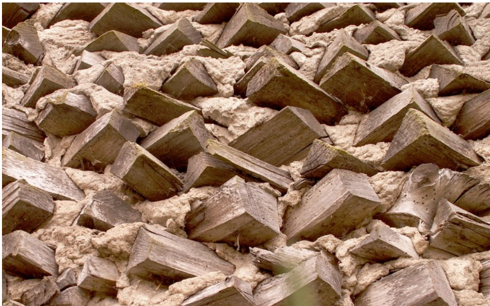
Ryc. 84 i 85. Fragmenty drewnobetonowej ściany w Mężeninie Kolonii; fot. autor, 2008
