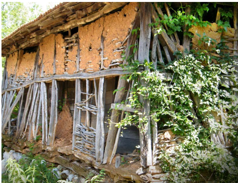
Ryc. 7. Stary spichrz z kompozytu drewnoglinianego (o ścianach mających konstrukcję pokrewną strychulcowej) w serbskiej wsi Rautowo przy południowym krańcu miasta Nisz; fot. autor, 2016
