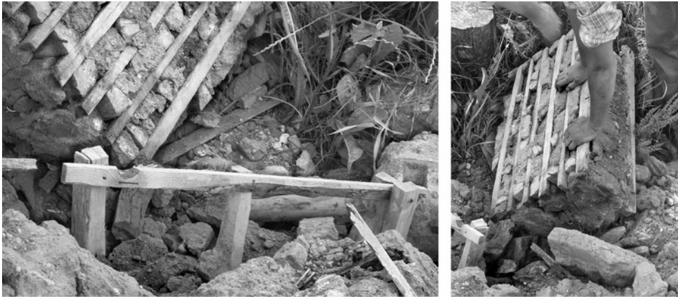
Ryc. 2. Fragmenty wyburzonej drewnobetonowej ściany domu we wsi Zacisze na Białostocczyźnie; fot. autor, 2009
