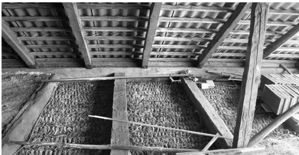
Ryc. 43. Strychulcowy strop domu we wsi gminnej Rudka na Podlasiu (wypleciony na sucho i polepiany tylko od dołu); fot. autor, 2008
