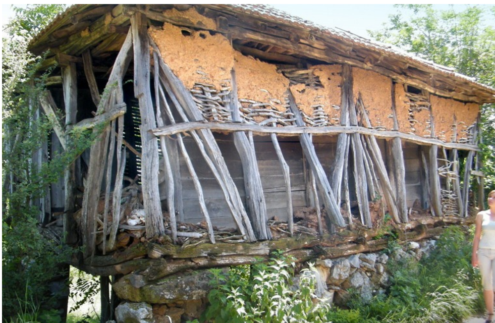
Ryc. 40 i 41. Przykłady konstrukcji bondruk : drewniano-gliniane budynki gospodarcze we wsi Rautovo niedaleko miasta Nisz; fot. autor, 2016
