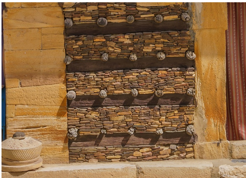
Ryc. 19. Powiększenie konstrukcji kamiennych ścian z drewnianymi wzmocnieniami w kościele przyklastornym na górze Debre Damo w Etiopii (fragment ilustracji 18)
