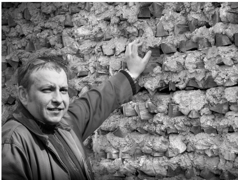
Ryc. 67. Drewnobetonowa ściana domu w Mężeninie; fot. autor, 2008
