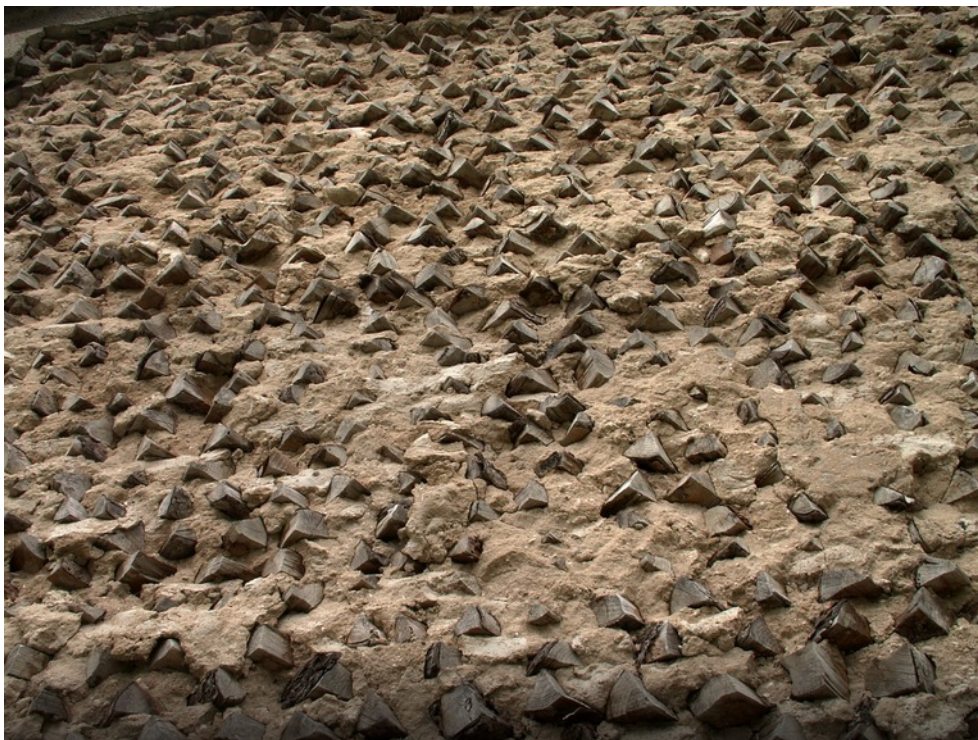
Ryc. 63 i 64-65 (obok). Drewnobetonowa ściana domu w Wyszonkach Kościelnych w gminie Klukowo na Białostocczyźnie, wzniesionego około 1950 roku metodą niewierowiczowską; fot. autor, 2009
