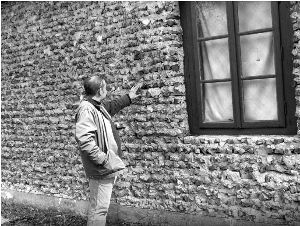
Ryc. 66. Drewnobetonowa ściana domu w nadbużańskim Mężeninie w gminie Platerów; fot. autor, 2008
