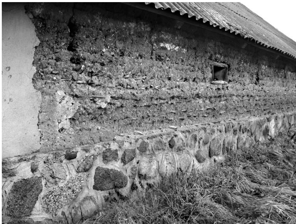
Ryc. 62. Chruściano-gliniana ściana budynku gospodarczego we wsi Kulesze w rejonie oszmiańskim obwodu grodzieńskiego na Białorusi; fot. W. Prychacz 60
