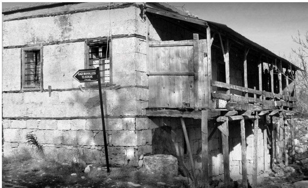
Ryc. 29. Dom z tufu wulkanicznego, wzmocniany drewnianymi listwami hatul ; źródło: Wikimedia Commons ( https://commons.wikimedia.org/wiki/File:Bir_ev_uzunca_burç_-_panoramio.jpg , na licencji CC-BY 3.0, fot. Haluk Comertel, 2008)
