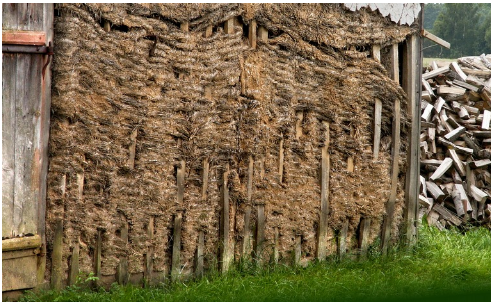
Ryc. 32. „Lepiankowa” ściana szopy we wsi Wyszonki-Wypychy w gminie Klukowo w zachodniej Białostocczyźnie; fot. autor, 2009
