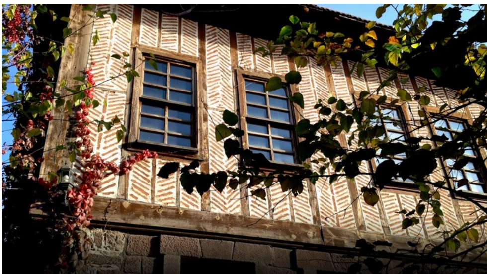
Ryc. 31. Ściana starego domu w Ankarze w środkowej Turcji o konstrukcji typu hımış z wypełnieniem ceglany; źródło: Wikimedia Commons ( https://commons.wikimedia.org/wiki/File:Old_Turkish_Houses_Ankara.jpg , na licencji CC-SA 4.0, fot. użytkownik Pivox, 2017)
