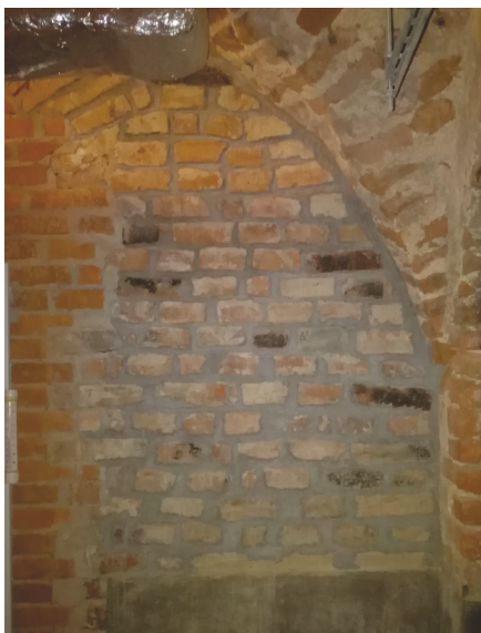
RYS. 6.4. Cyfrowy i termograficzny obraz fragmentu wschodniego sklepienia i muru hydroforni Zamku Biskupiego po zastosowaniu warstwy uzupełniającej, poziom -2
