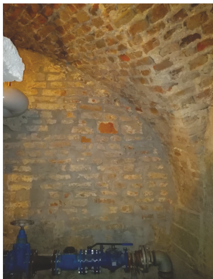
RYS. 6.2. Cyfrowy i termograficzny obraz fragmentu zachodniego sklepienia i muru hydroforni Zamku Biskupiego po zastosowaniu warstwy uzupełniającej, poziom -2
