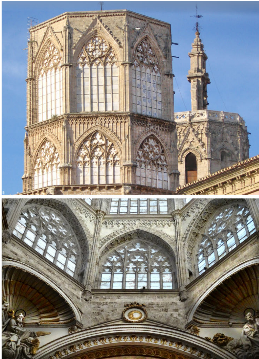
Ryc. 12. Alabastrowe okna katedry wzniesionej w latach 1262-1356 w Walencji (wg Wikimedii Commons)
