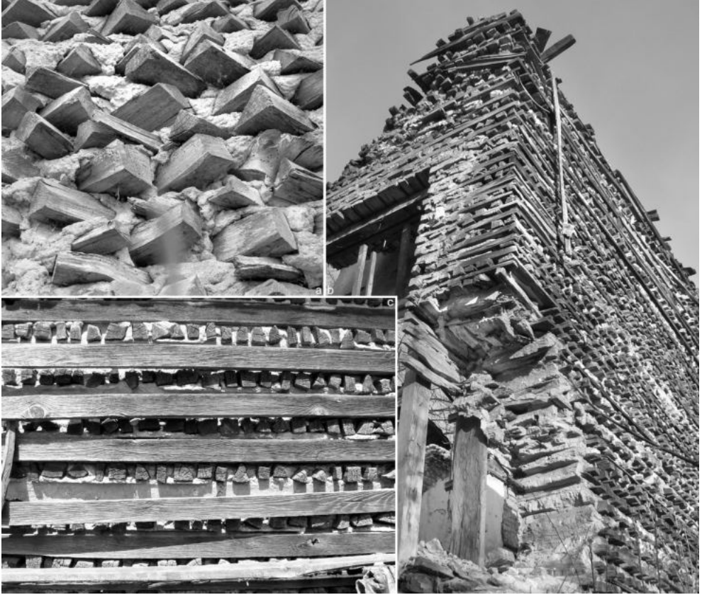
Ryc. 63. Ściany z drewna opałowego na Podlasiu (fot. autor, 2007-2008)
