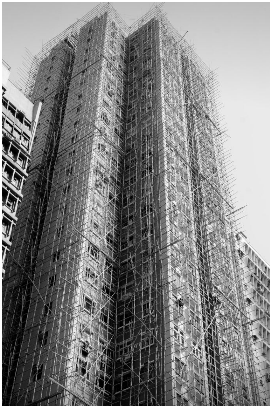
Ryc. 23. Rusztowania bambusowe wokół jednego z wysokościowców w Hongkongu (wg Wikimedii Commons)
