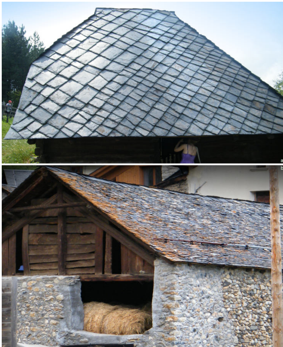
Ryc. 16. Różne rodzaje ardezowych (łupkowych) pokryć dachowych: a) w skansenie Sirogojno w Serbii; b) w hiszpańskich Pirenejach (fot. autor, 2016 i 2013)
