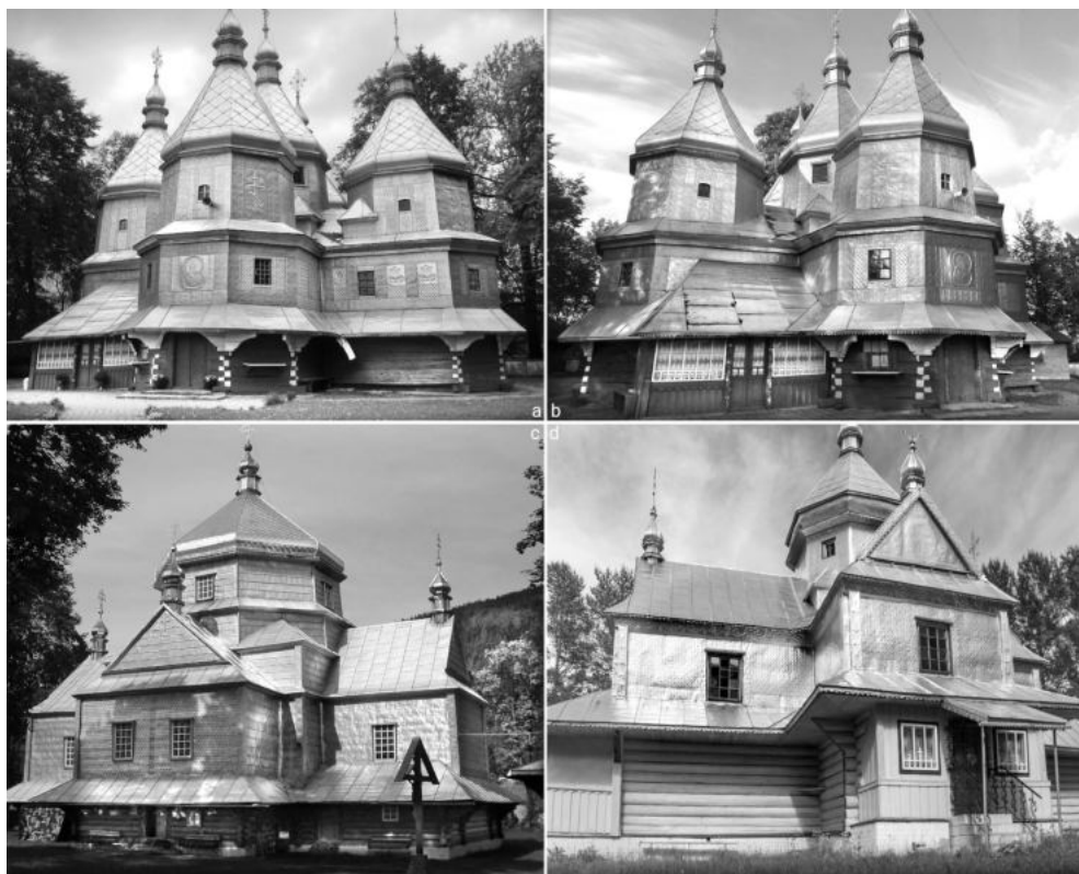
Ryc. 29. Blaszane dachy i obicia ścian drewnianych cerkwi ukraińskich: a-b) w Wierbiażu Niżnim, c) w Mikuliczach, d) w Bereźnicy (wg Wikimedii Commons)
