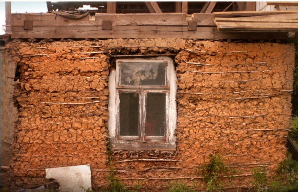
Рис. 50. Глинобитка збројена хрустем: проект спихрца з 1909 року, пониже дом в Залесіу в гміні Вышкі на Бялосточчыніе (зрѣдла: [501], фот. автор, 2008)
