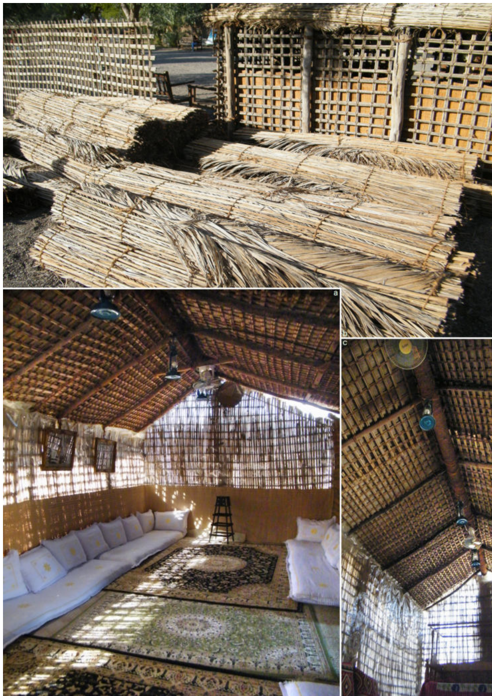
Ryc. 59. Belkowanie z kłódzin daktyłowca, nakryte matami daktyłowymi w budynkach skansenu w emiracie Fudżajra (ZEA; fot. autor, 2017)
