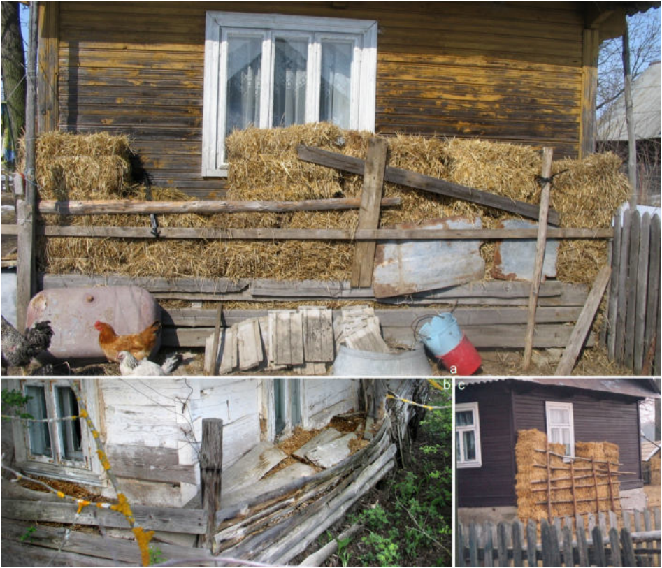
Ryc. 98. Ogacanie chałup kostkami słomy (fot. studenci WA PB, ok. 2005-2007)
