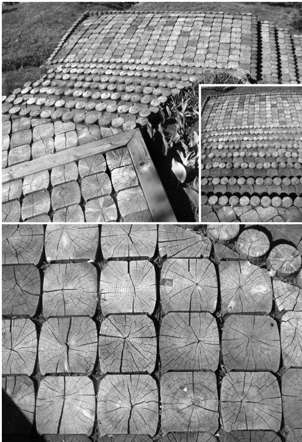
Ryc. 96. „Bruk drewniany”, czyli drewniana kostka posadzkowa (fot. autor, 2007)
