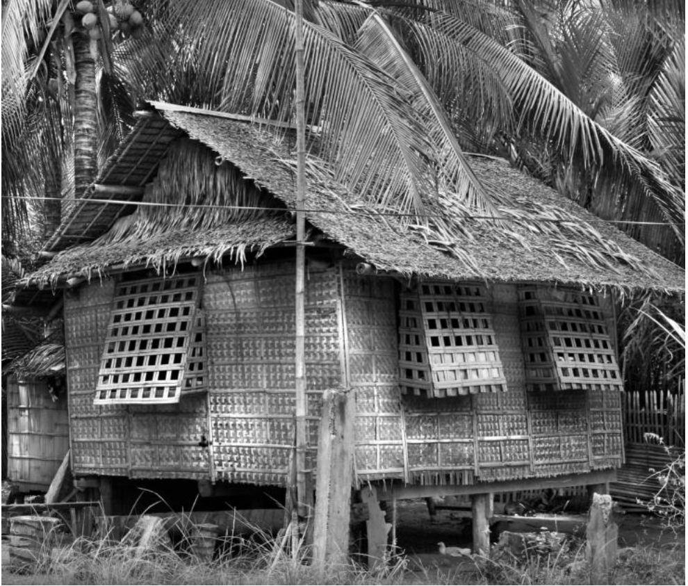
Ryc. 22. Dom w prowincji Aklan na Filipinach, wykonany z bambusowej plecionki amakan (wg Wikimedii Commons)
