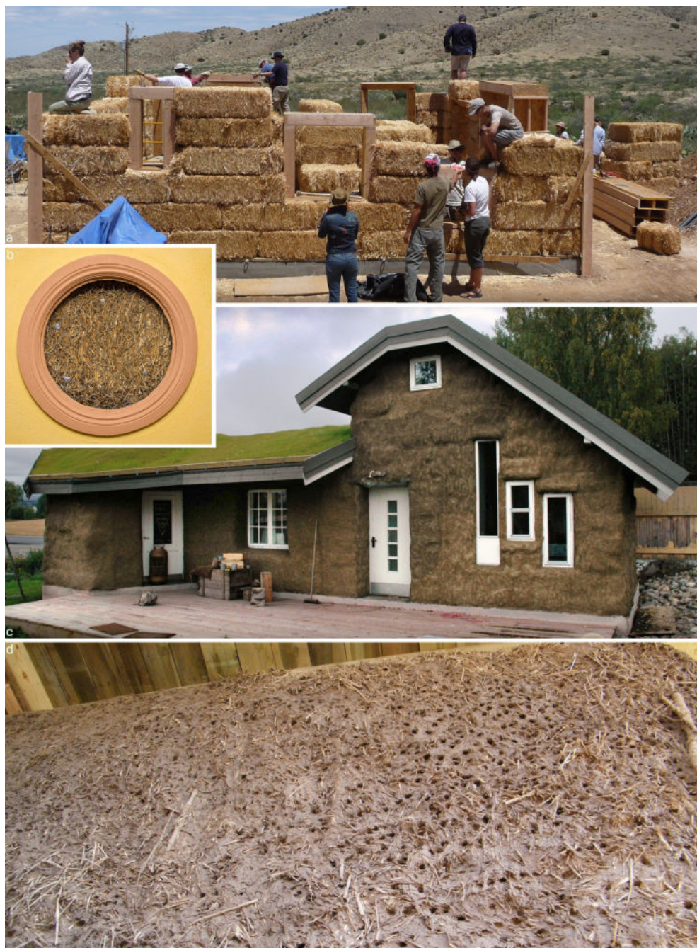
Ryc. 97. Budownictwo z kostek słomianych (wg Wikimedii Commons i materiałów własnych): a) konstrukcja samonośna; b) tzw. okienko prawdy; c) dom z kostek słomianych tynkowany łąjmem z gliną; d) pierwsza warstwa tynku na ścianie z kostek słomianych w podbiałostockim Henrykowie
