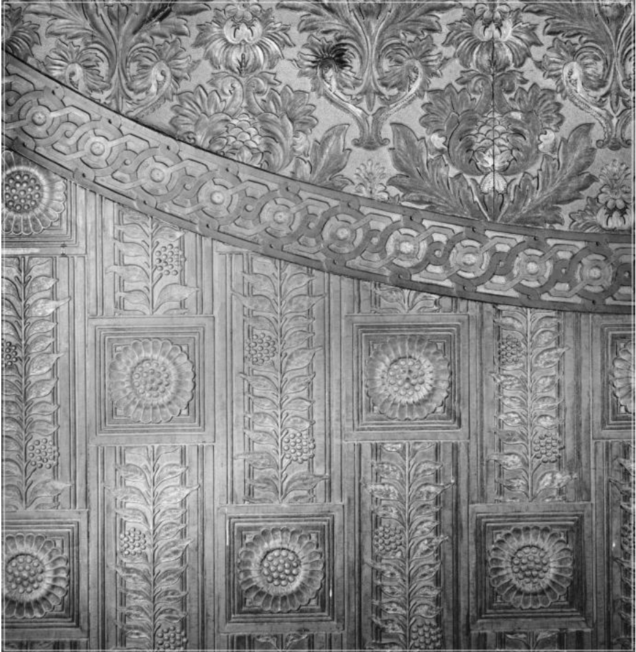
Ryc. 110. Ściana pokryta linkrustą (wg Wikimedii Commons)
