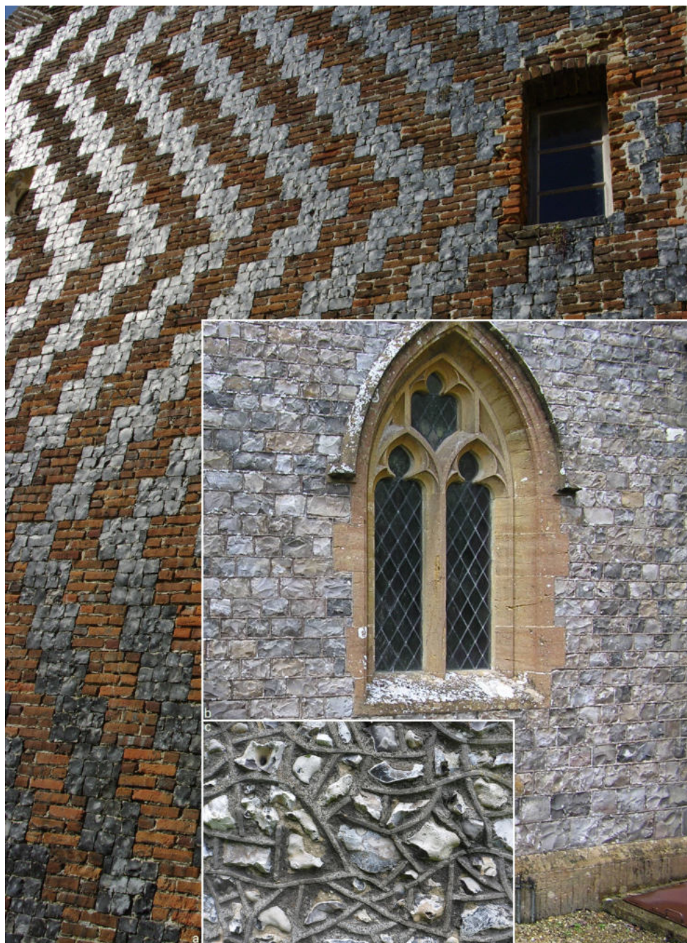
Ryc. 102. Krzemienne ściany budynków (wg Wikimedii Commons):
