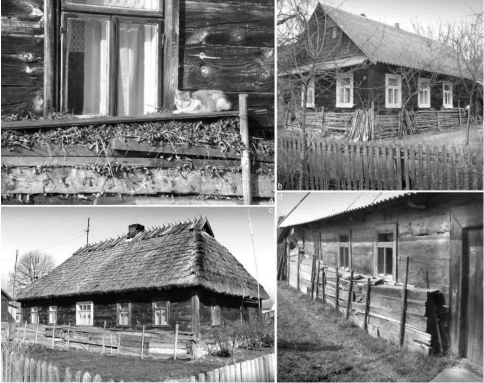
Ryc. 48. Zagaty – sezonowe ocieplenia chałup podlaskich, wypełnione chrustem i igliwem (z archiwum Wydziału Architektury Politechniki Białostockiej, 2005)
