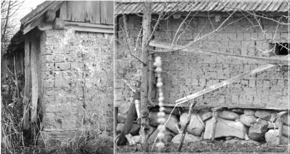
Ryc. 46. Ściany budynków z surowej cegły w północnopodlaskiej wsi Nowodziel (lata pięćdziesiąte XX wieku; fot. stud. z archiwum Wydziału Architektury Politechniki Białostockiej, 2005)
