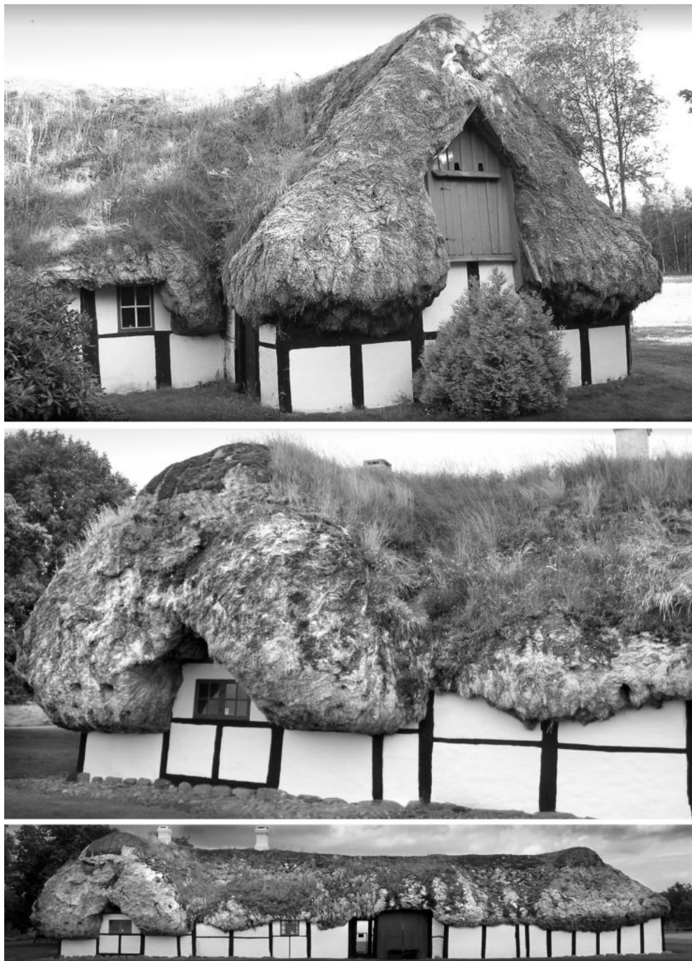
Ryc. 13. Kryte algami dachy chałup na duńskiej wyspie Læsø (wg Wikimedii Commons)
