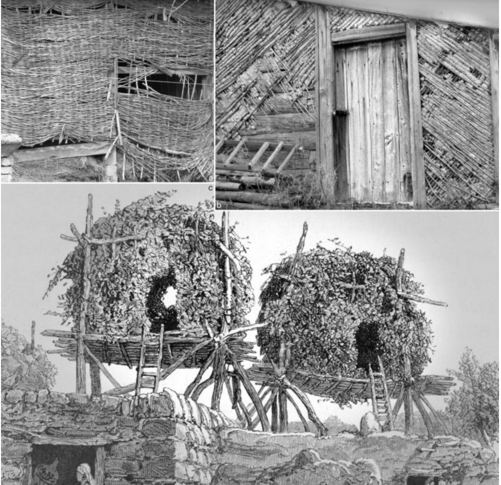
Ryc. 73. Chrust i gałęzie w dawnym budownictwie: a) pleciona stodoła pod Opatowcem (fot. autor, 2014); b) podtynkowe oblistwowanie drewnianej ściany prętami leszczynowymi (fot. studenci WA PB, 2003); c) szałas w Banjas na Wzgórzach Golan (rys. Harry Fenn, 1881)
