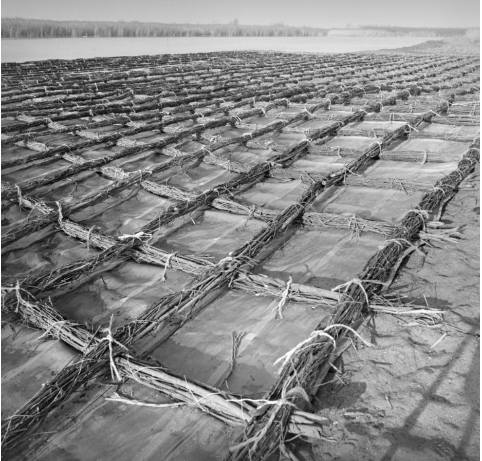
Ryc. 69. Materac stabilizujący faszynowo-tekstylny z komorami wypełnianymi gruzem (fot. z zasobów holenderskiego Nationaal Archief, 1968; domena publiczna)
