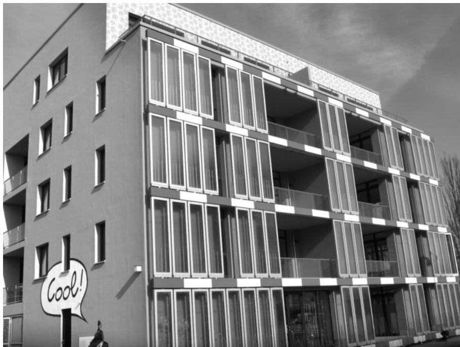
Ryc. 14. Dom z fasadą bioreaktywną z glonów (alg) przy Am Inselpark 17 w Hamburgu (wg Wikimedii Commons)
