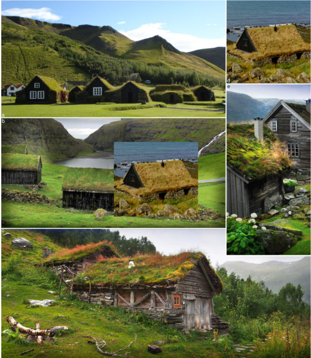
Ryc. 61. Darniowe pokrycia dachów w Norwegii, na Islandii i Wyspach Owczych:
