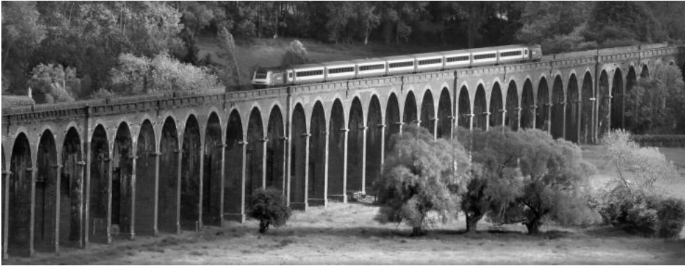
Ryc. 47. Wiadukt z 1878 roku na rzece Welland w Haringworth, licowany cegłą siwą (wg Wikimedii Commons)
