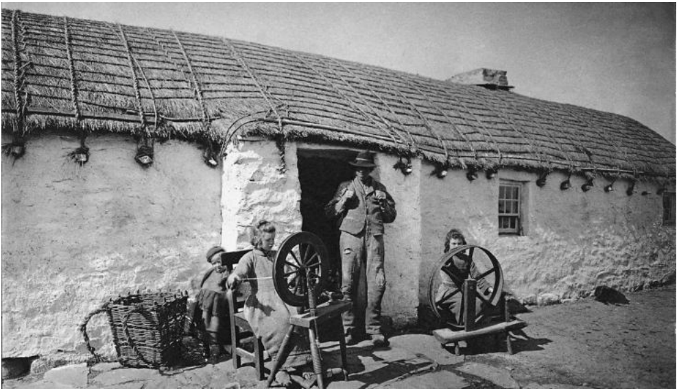
Ryc. 109. Irlandzka chałupa kryta strzechą wiązaną linami okrętowymi (wg Wikimedii Commons)
