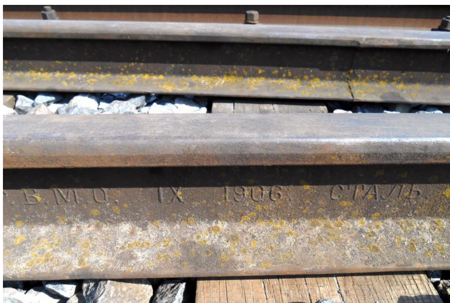
Rosyjska szyna z września 1906 r., ciągle w użyciu w pobliżu stacji kolejowej w Bielsku. Jest tam i druga szyna z 1910 r. Szyny odnalazł i wskazał E. Antoniuk
