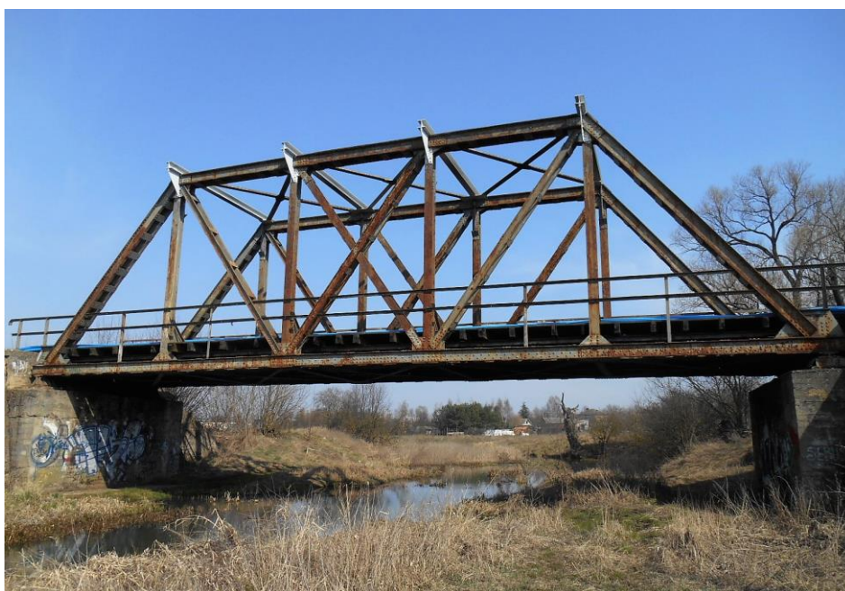
„Żelazny most” na rz. Białej w Bielsku Podlaskim. Górne belki łączące boczne dźwigary wymieniono w 2018 lub 2019 r. Fot. Janusz Porycki 28 III 2020 r.
