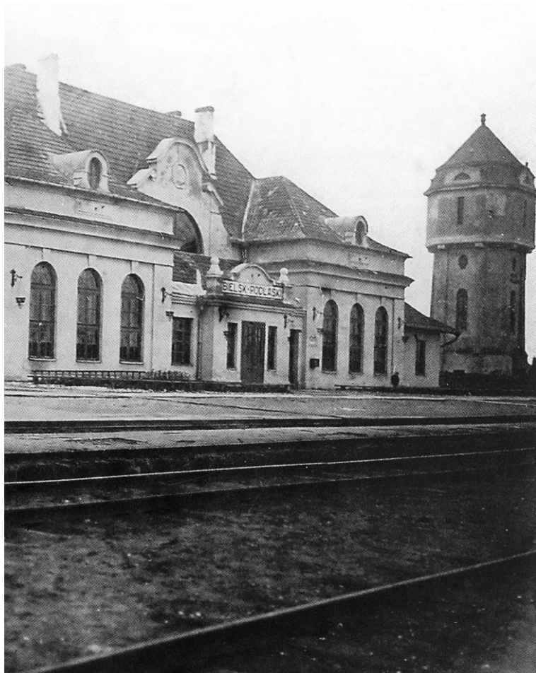
Bielsk Podlaski. Dworzec kolejowy i wieża ciśnieniowa od strony miasta. Fot. lata 30. XX w.
