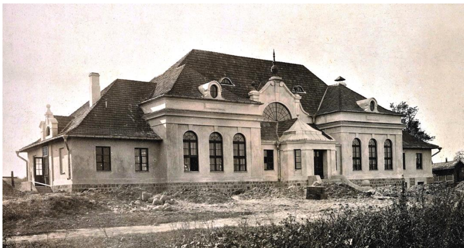
Dworzec kolejowy w Bielsku Podlaskim w fazie wykończeniowej. Brakuje jeszcze pięciu komi- nów. Widok od podjazdu (od miasta). Fot. z ok. 1925 r. Ze zbiorów Biblioteki Narodowej w Warszawie
