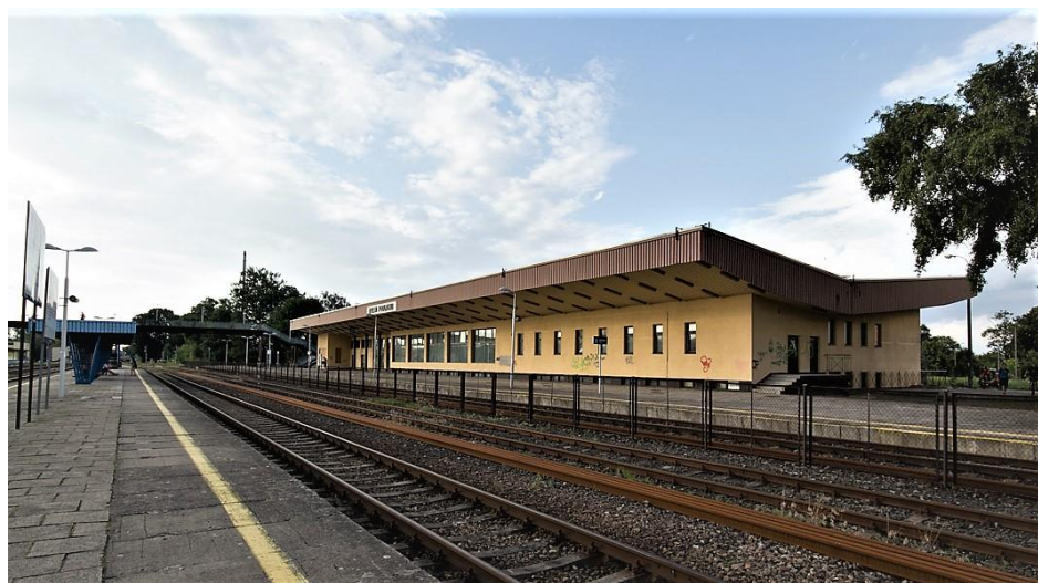
Dworzec w Bielsku od strony torów. Fot. Anna Sruga PKP-Polskie-Linie-Kolejowe-S.A., 2018 r.
