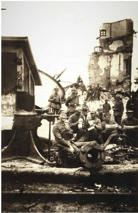
Wieża ciśnień w Bielsku wysadzona w sierpniu 1915 r. Grupa Niemców dokonuje prac rozbiórkowych (fot. ze zbioru Doroteusza Fionika)
