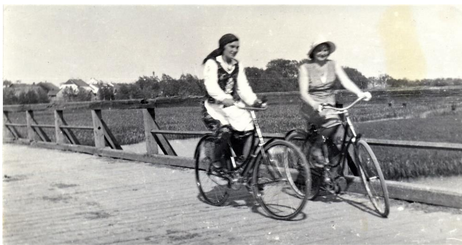
Fragment drewnianego mostu w Brańsku około 1933 r. Widoczna część szerokiej, bagnistej doliny Nurca (przed melioracją). Fot. A. Kaleszuk
