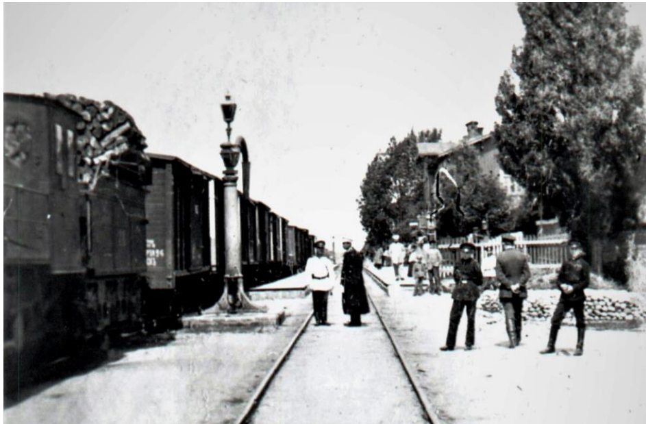
Stacja kolejowa w Bielsku Podlaskim na pocz. XX w. Z lewej pociąg towarowy, żuraw do napełniania wodą parowozu, z prawej peron i budynek dworca. Fot. ze zbiorów ze zbiorów Wojewódzkiego Urzędu Ochrony Zabytków w Białymstoku
