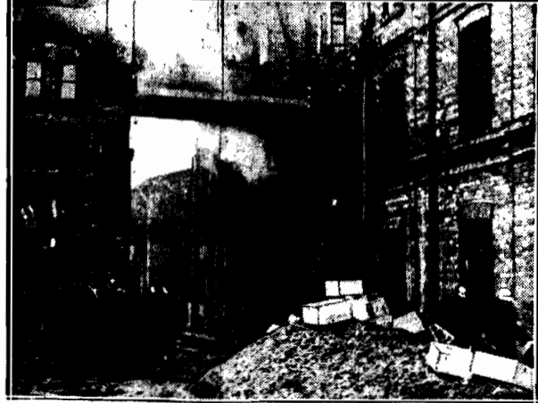
Podwórze domu Nr. 54 przy ul. Żelaznej, gdzie wybuchł wczoraj groźny pożar w składach mebli firmy „Thonet-Mundus”.
