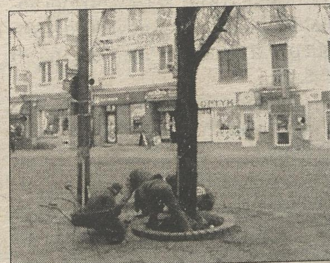
Prace przy ratowaniu drzew na ul. Lipowej dobiegają końca
