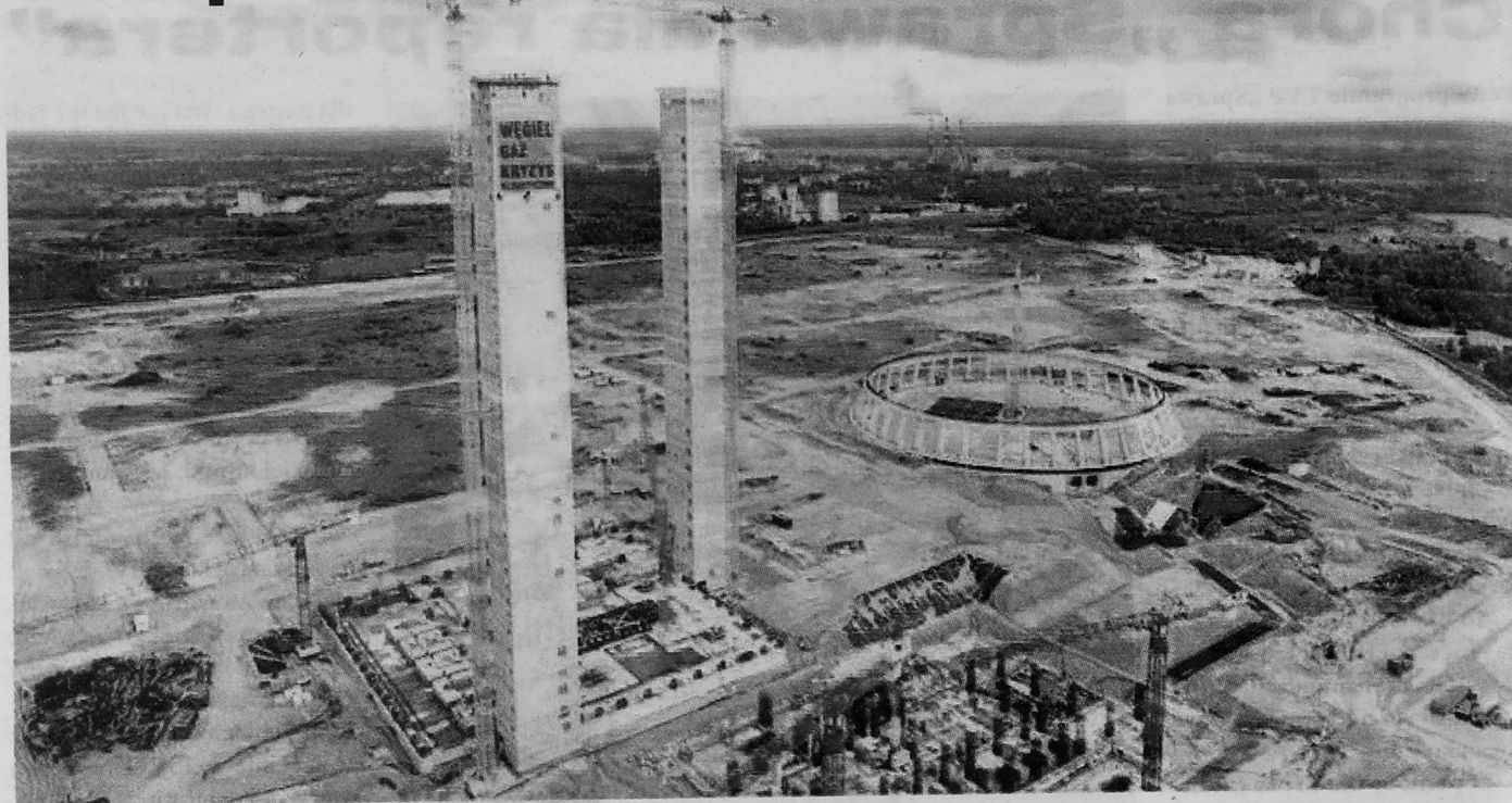
Po tych wieżach nie ma już śladu – po zbudowaniu zostały zburzone. Fot. Greenpeace Polska
