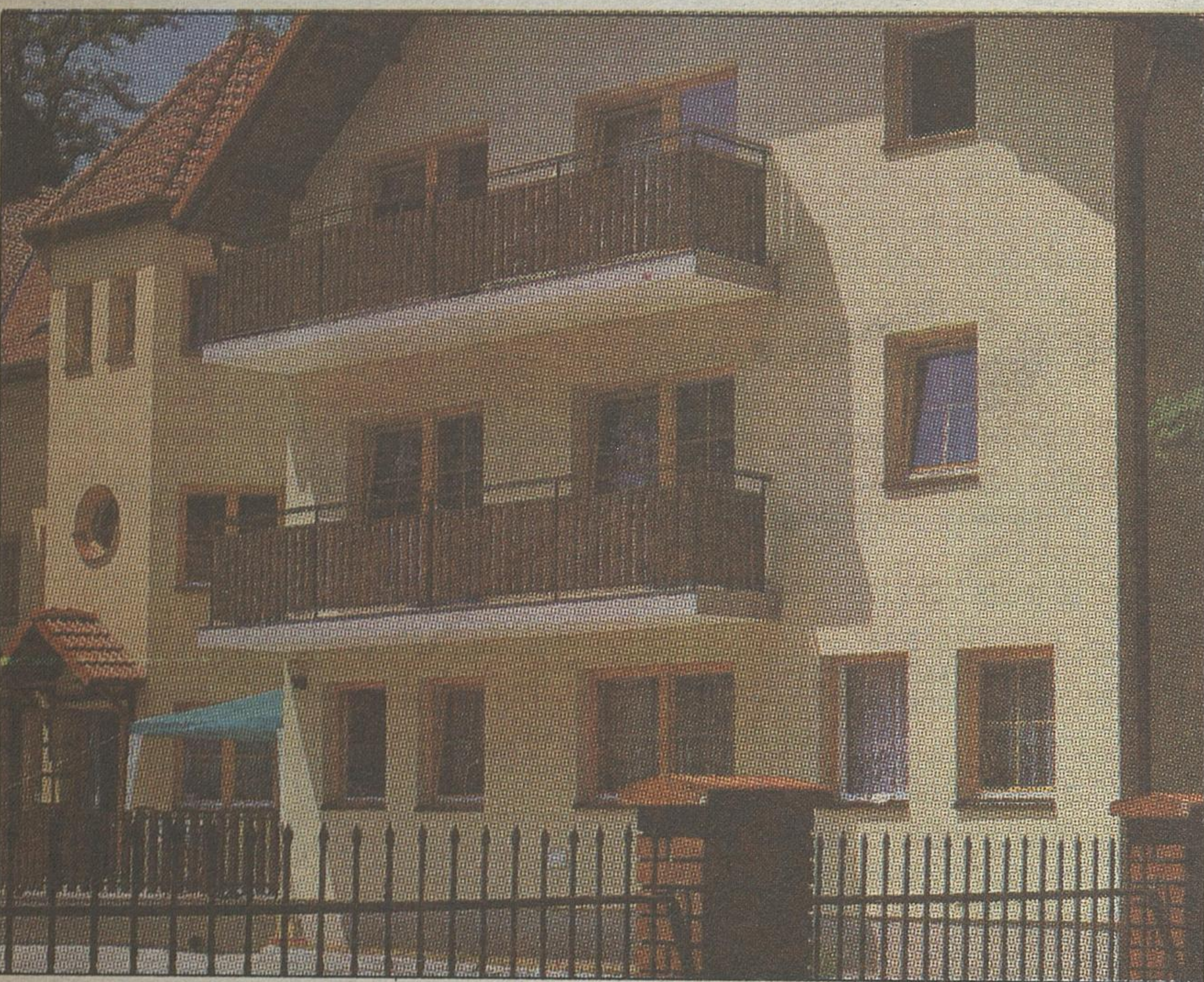
Przykład realizacji z zastosowaniem systemu Bolix
