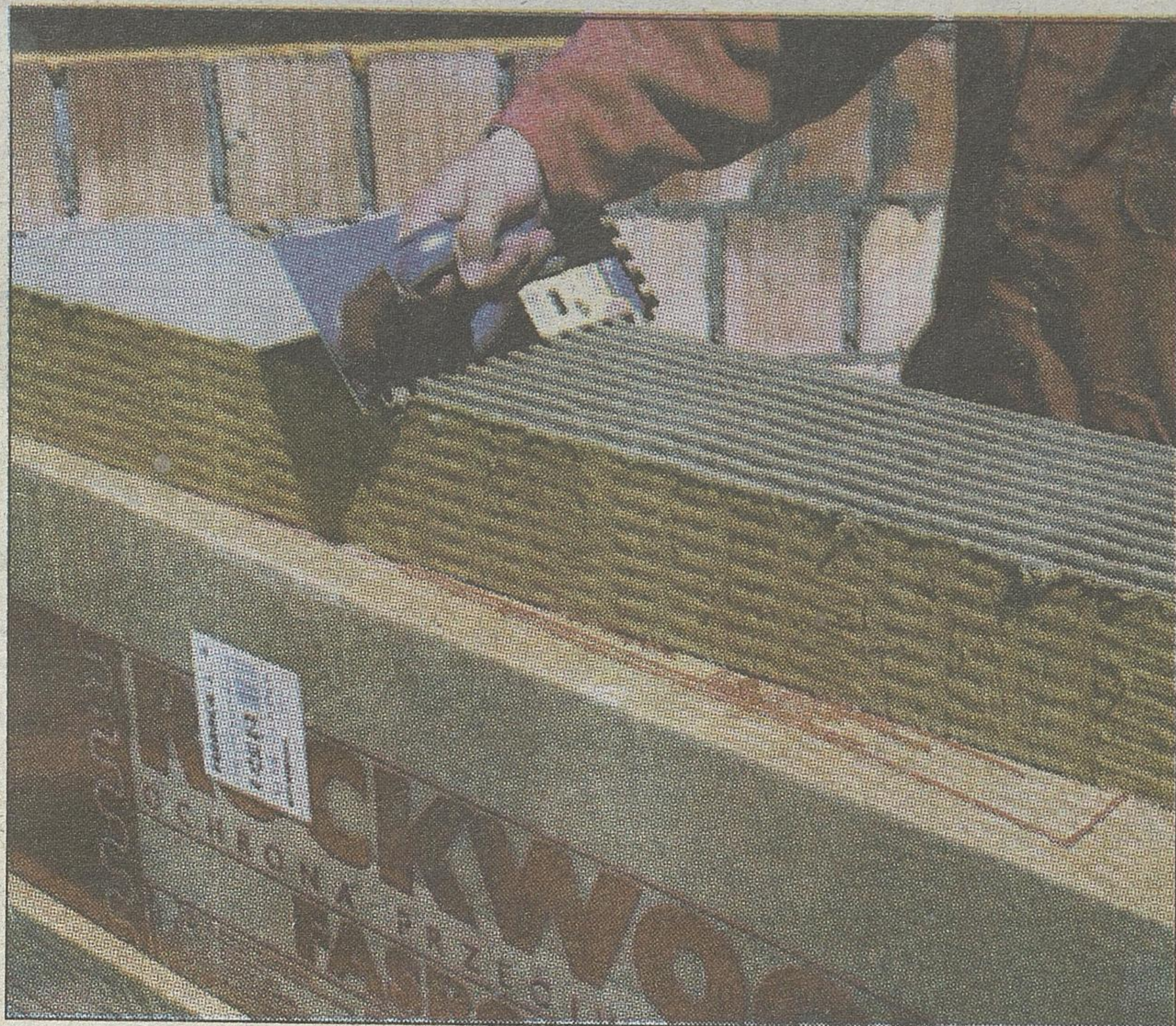
Prace wykonawcze systemu ociepleniowego Ecorock-L
