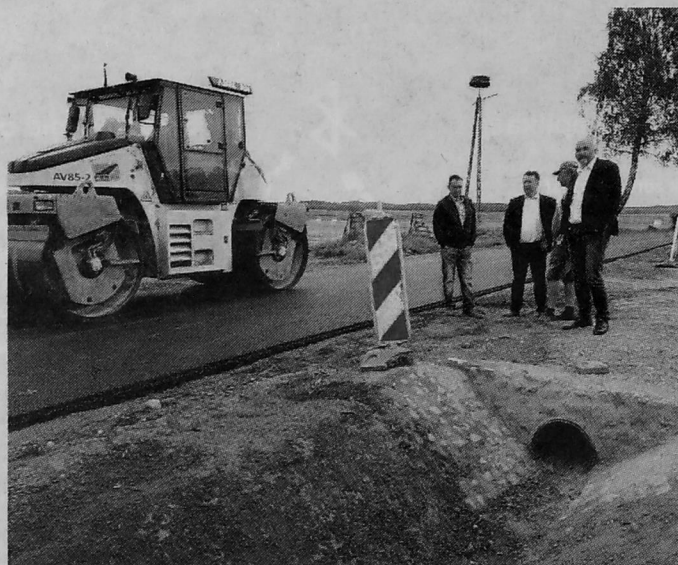
Budowa drogi gminnej w Brzózkach
