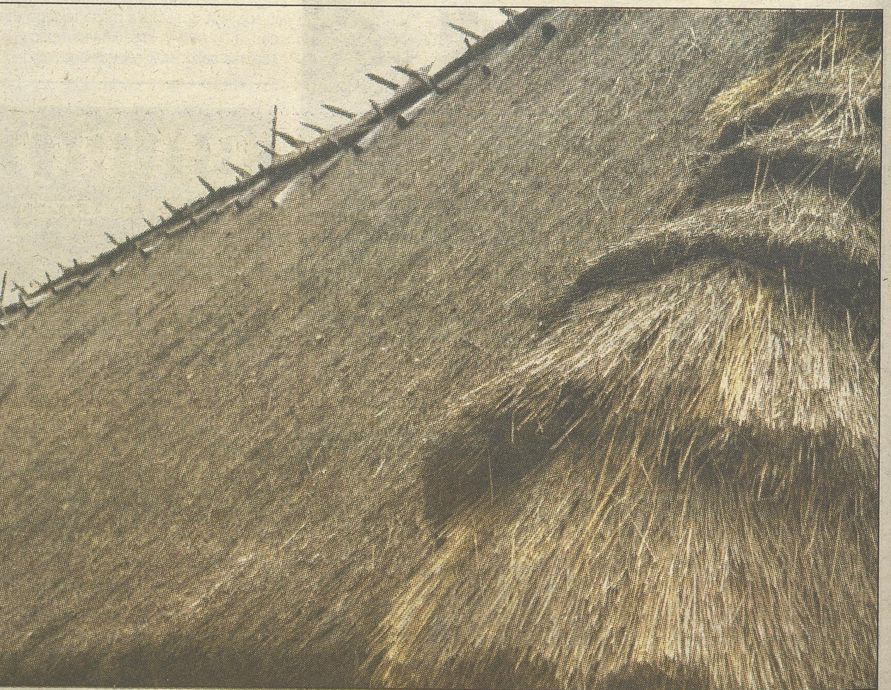
Dach ze strzechy jest ciepły, wodoszczelny i nie wymaga montowania rynien
