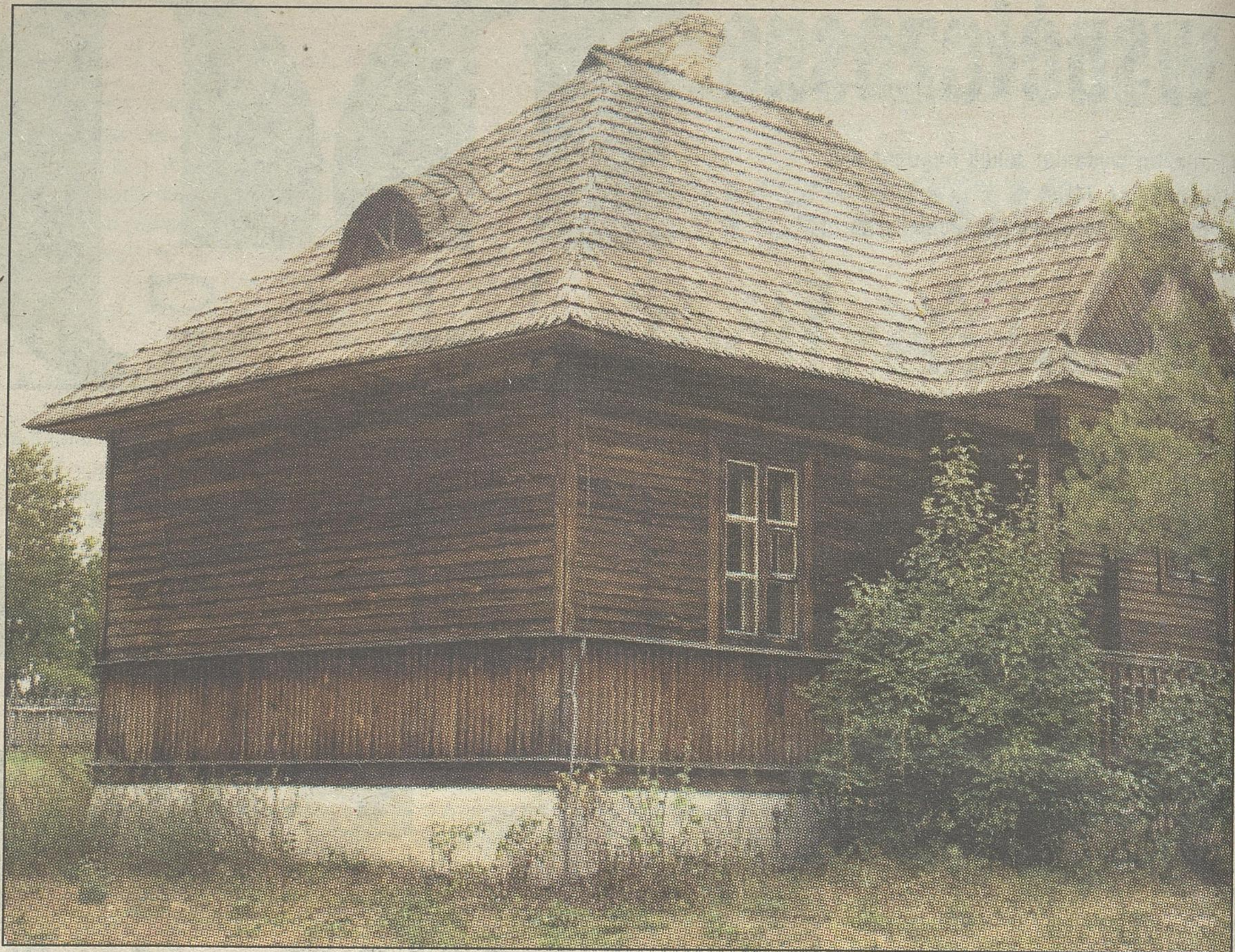
Prawidłowo wykonany i zamontowany dach drewniany jest trwały. Można go dodatkowo zaimpregnować
