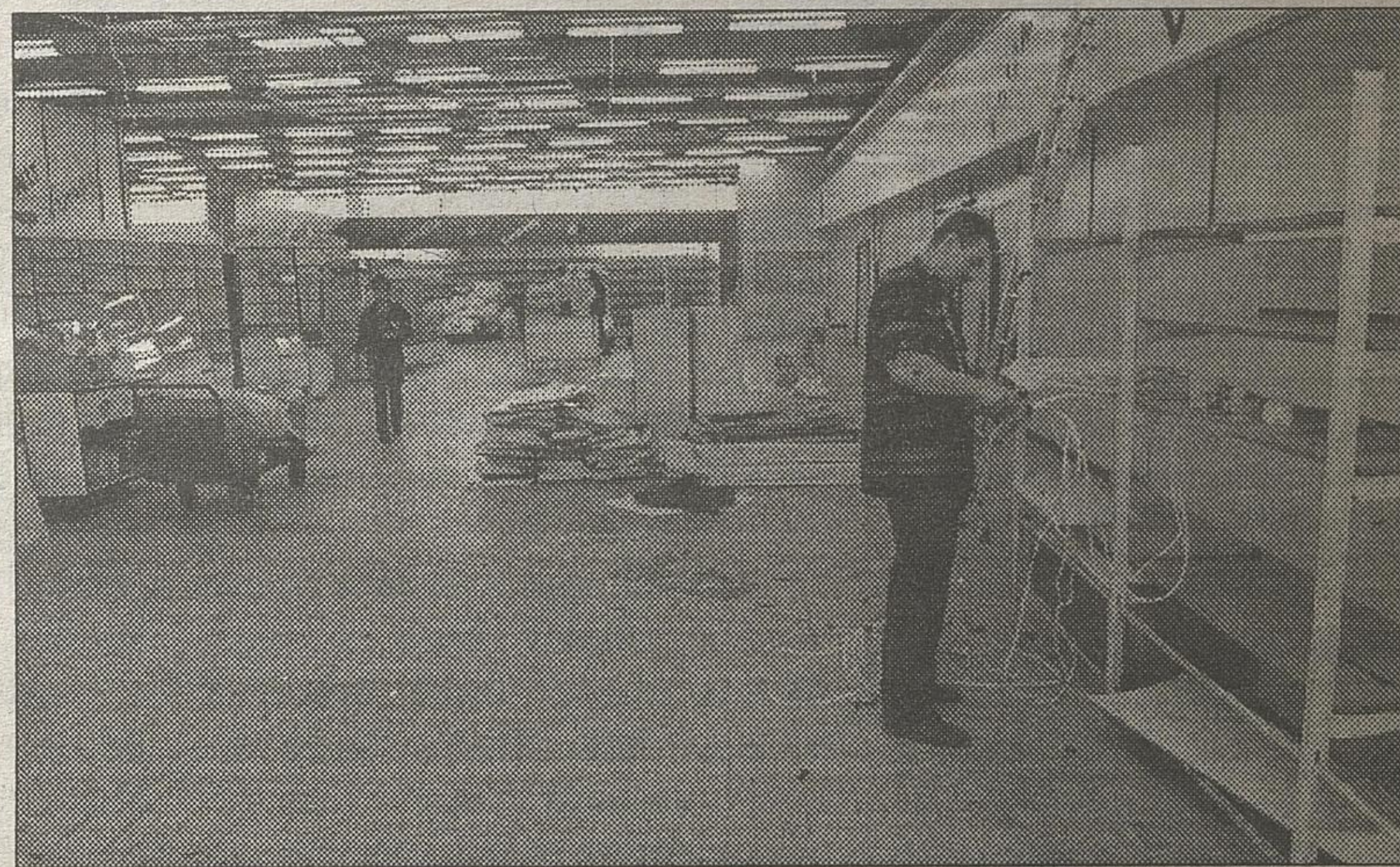
Remont potrwa do sierpnia
