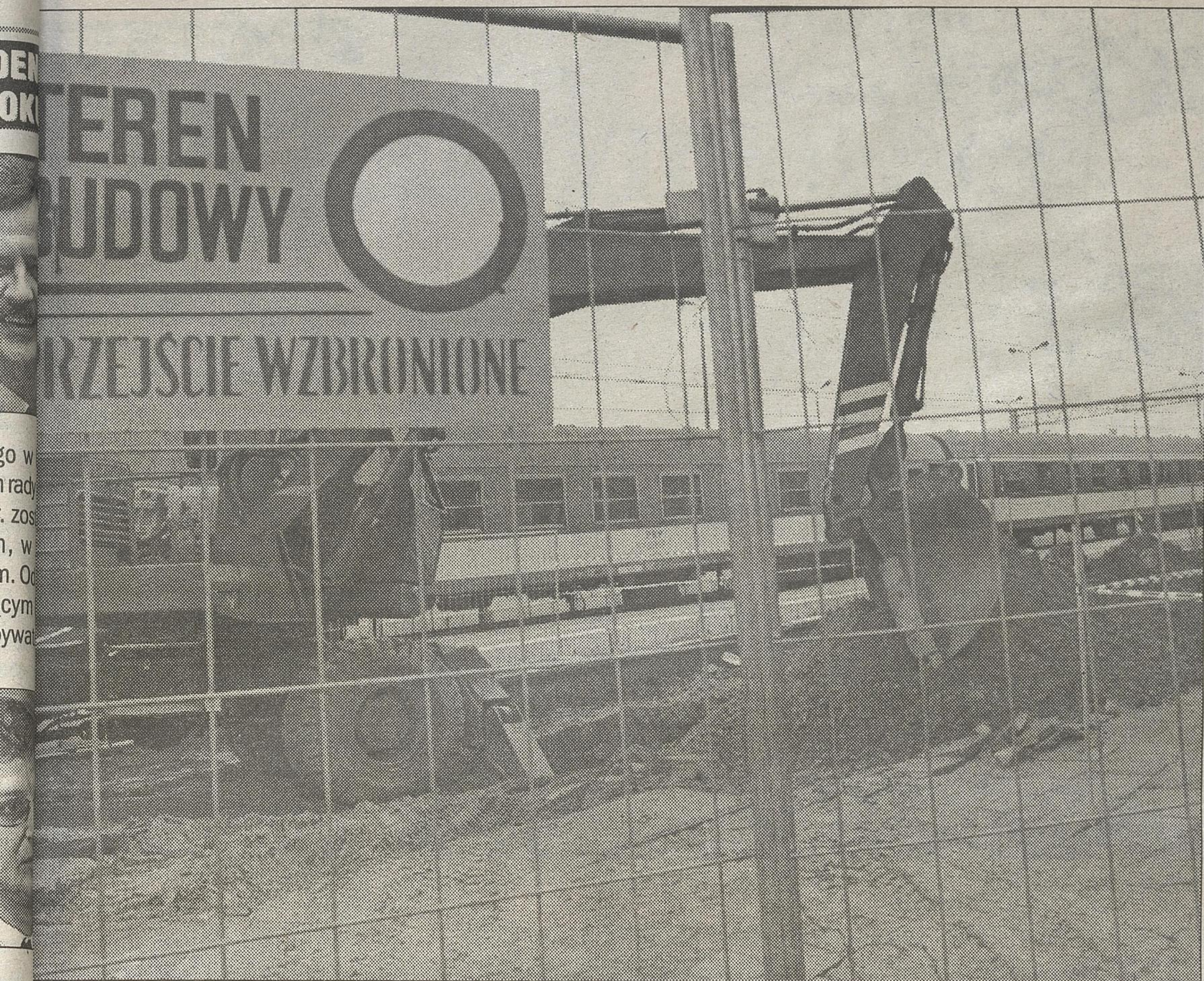
95-... już rozbiórka pierwszego peronu
