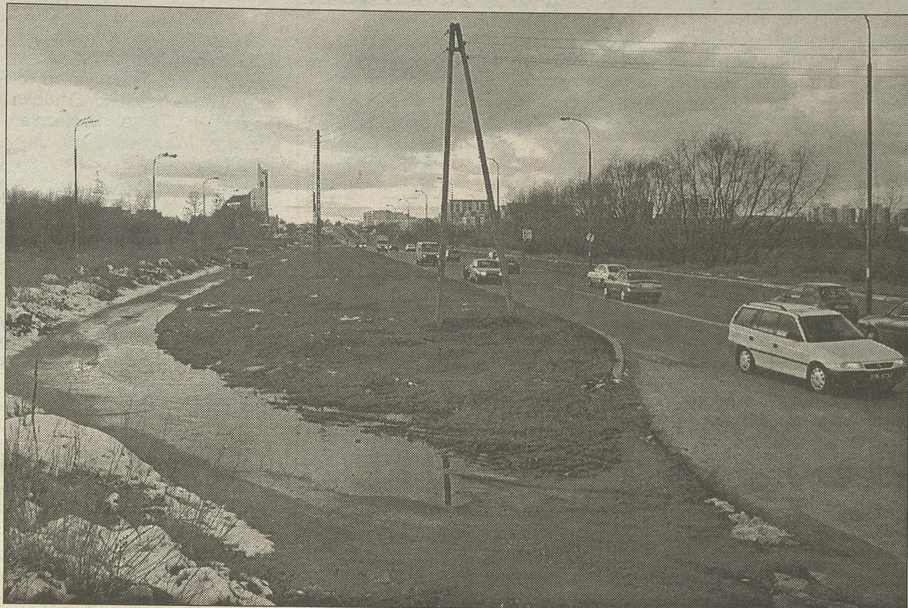
Nowa, trzypasmowa jezdnia, powstanie po lewej stronie, w miejscu starej ul. Popiełuszki (za czasów PRL ul. Gomułki), która była używana jeszcze w latach 80., zanim zbudowano istniejącą obecnie ulicę
