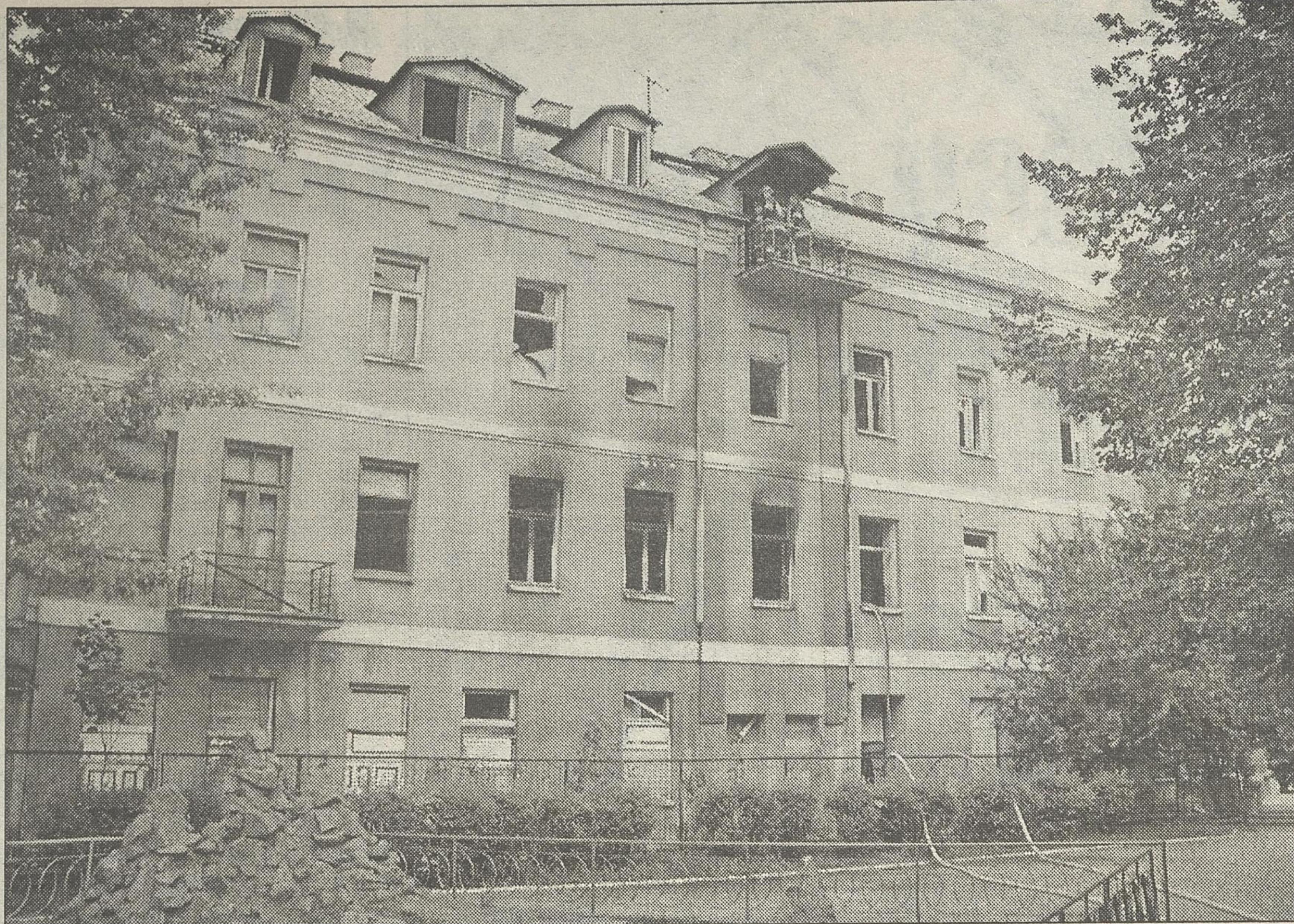
Ostatni pożar kamienicy przy ul. Częstochowskiej 6 z pewnością pomoże przyspieszyć decyzję o rozbiórce budynku stojącego na trasie przebiecia
