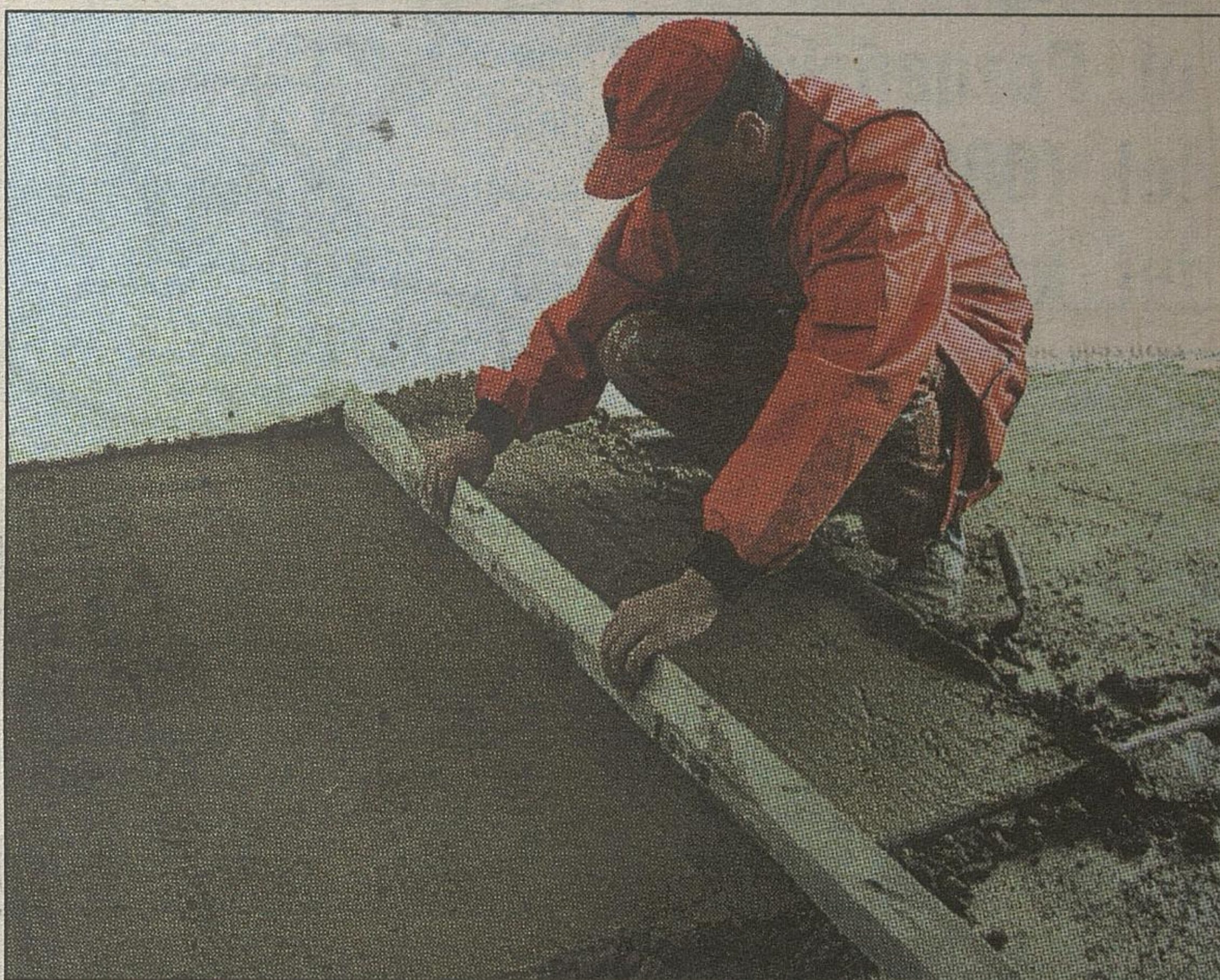
Następnie zaprawę zagęszczamy i ściągamy jej nadmiar, wykonując łatą zygzakowate ruchy
