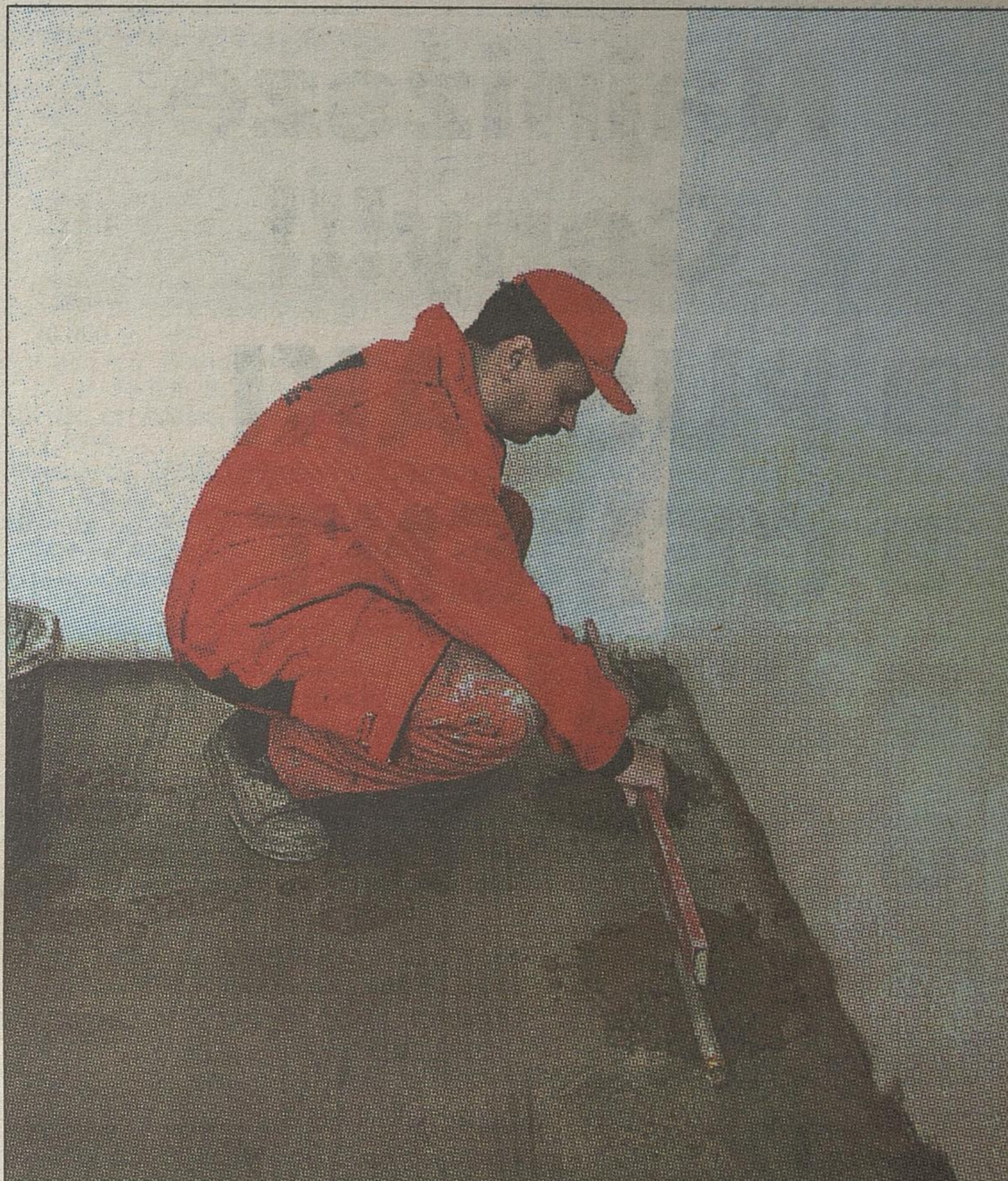
Prowadnice ustawiamy szczególnie starannie, gdyż ich górna płaszczyzna będzie wyznaczać wierzchnią warstwę posadzki
