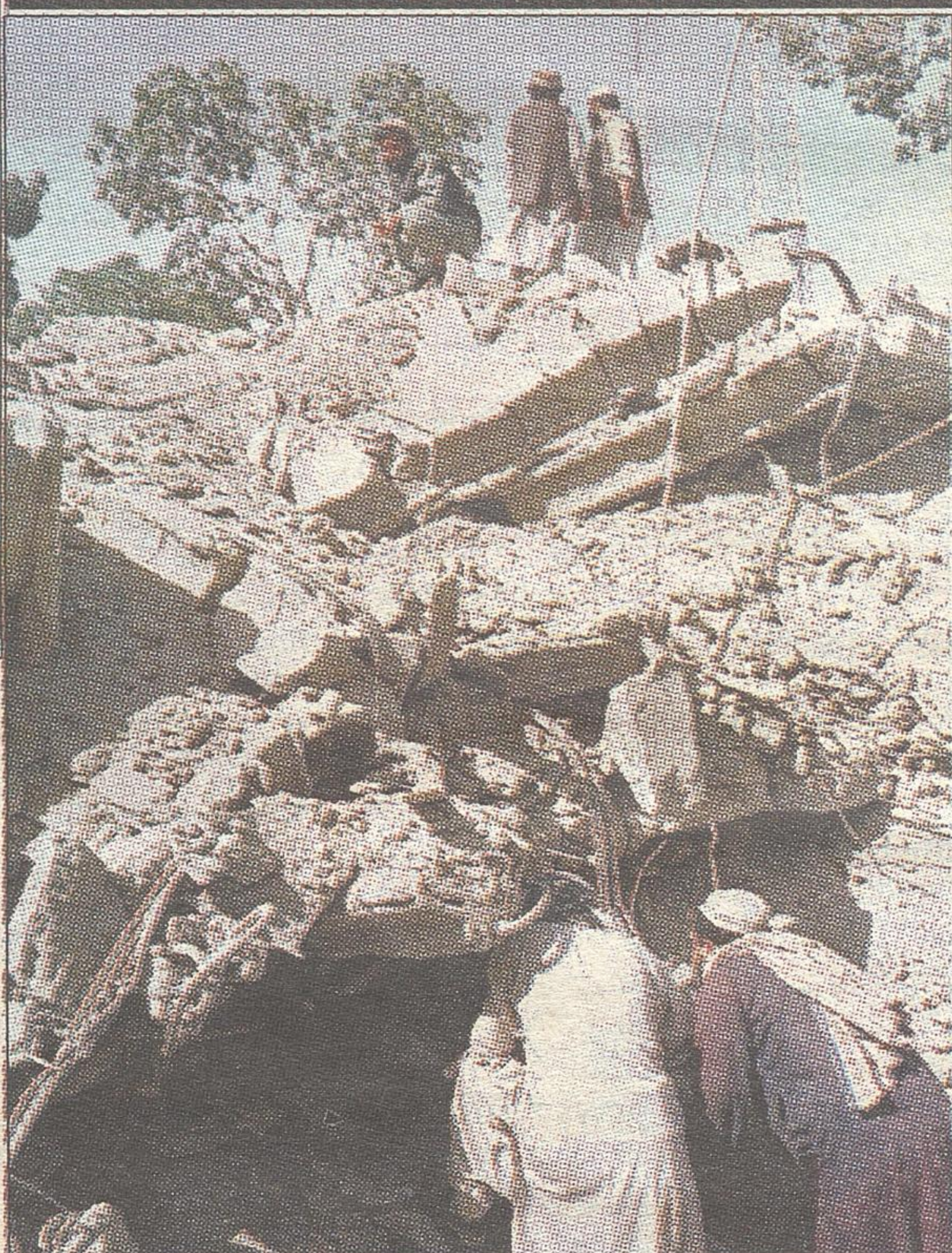
Mieszkańcy Kabulu szukają ciał ofiar w ruinach urzędu Afghan Technical Consultancy. Budynek ten był jednym z obiektów zniszczonych we wtorek podczas kolejnej fali amerykańskich nalotów.
