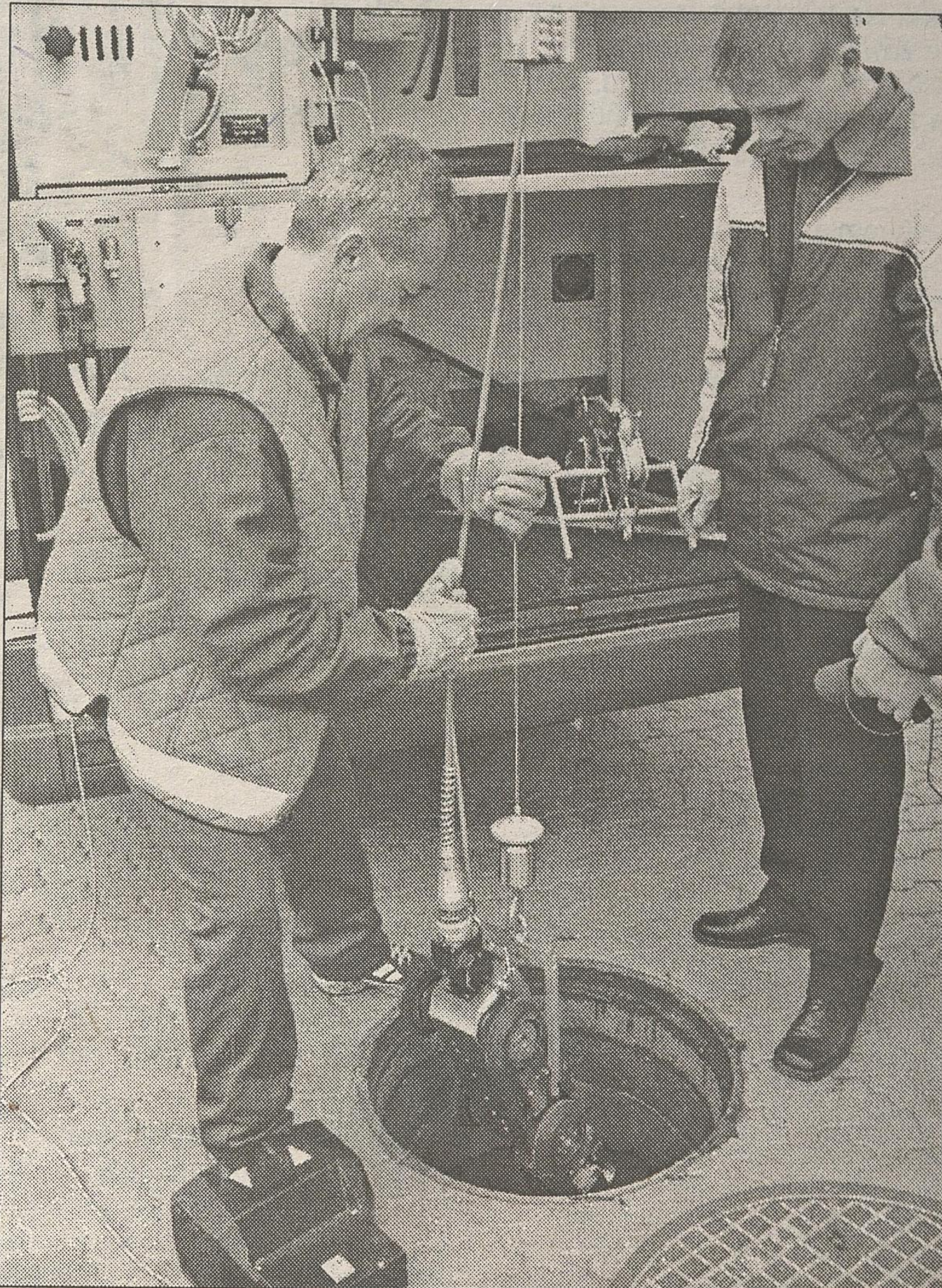
Dzięki specjalnej kamerze, pracownicy „Wodociągów Białostockich” kontrolowali wczoraj kanał pod ul. Niedźwiedzią
