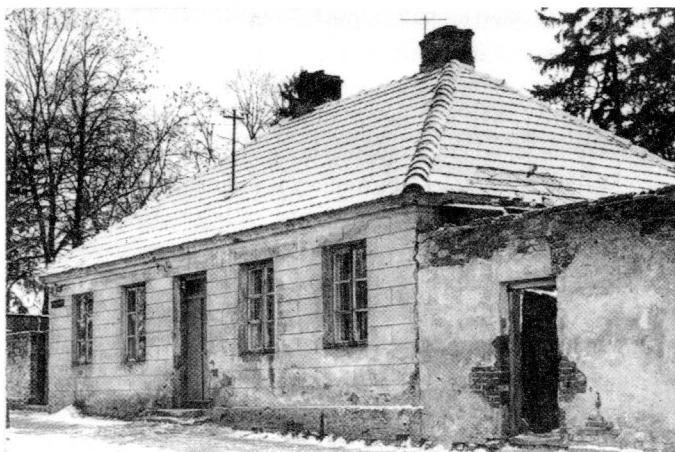
Dom Grabarza z 1853 r. Fot. z lat 70. XX w. Obecnie budynek odremontowany przez Firmę Pogrzebową „Epitafium”.
