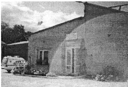
Budynek Hospicjum przed rozbudową.
