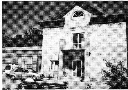
Budynek Hospicjum w trakcie rozbudowy.
