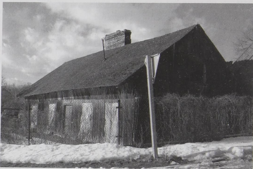
Wiekowy dom Oleszków jeszcze stoi w Drozdowie, ale dni jego są już policzone. Stan z marca 2010.
