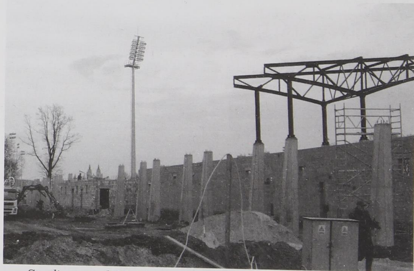
Stadion nad Narwią nie przechodził jeszcze takiego remontu. Trwa budowa zadaszonej trybuny głównej. Fot. Łukasz Czech
