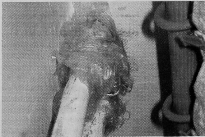
Alicja zabezpieczyła otwory przy rurach
