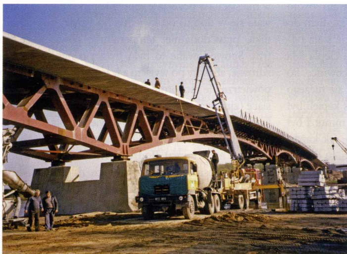
Tak budował się „nowy” most. Fot. Gabriela Szczęsna
