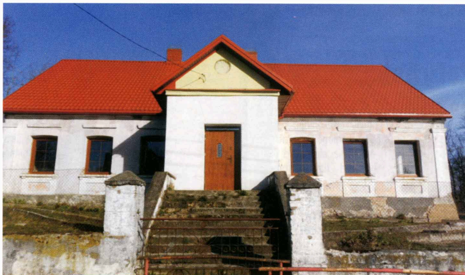
Budynek szkoły z 1892 r.
