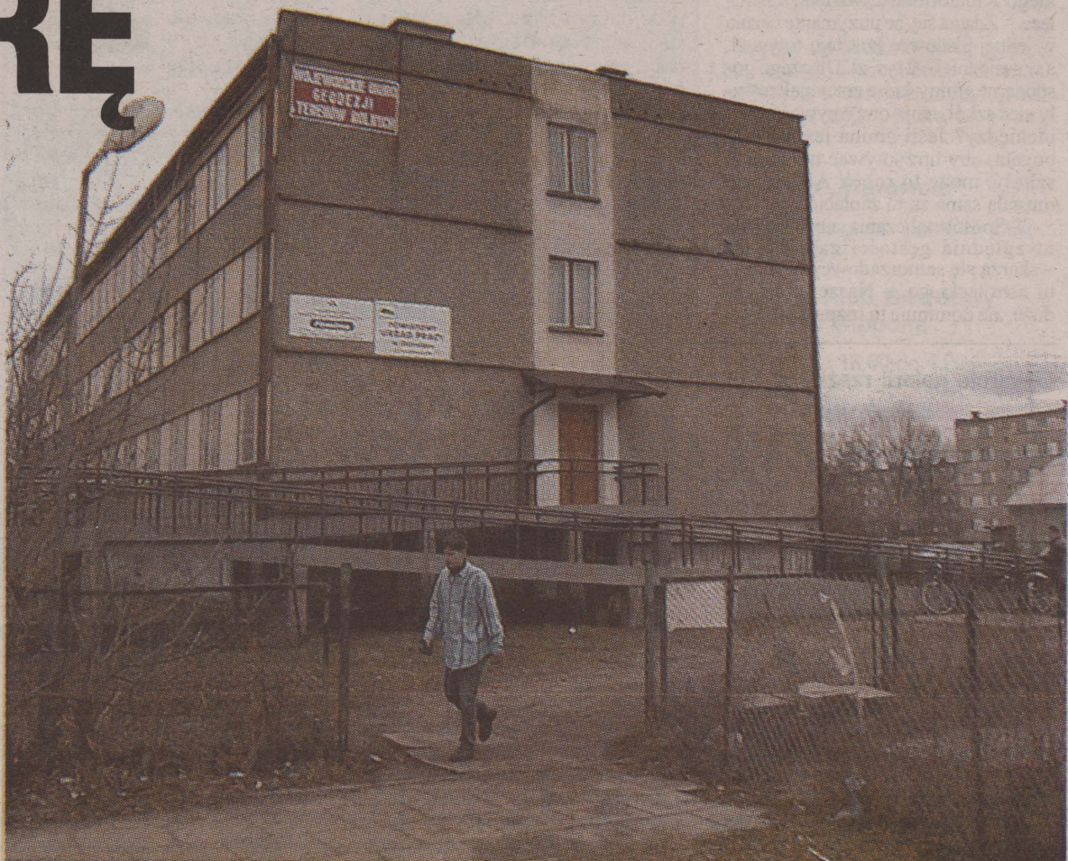
Gospodarzy budynku przy ul. 11 Listopada jest kilku, a tymczasem dostać się do niego można jedynie przez dziurę w ścianie
