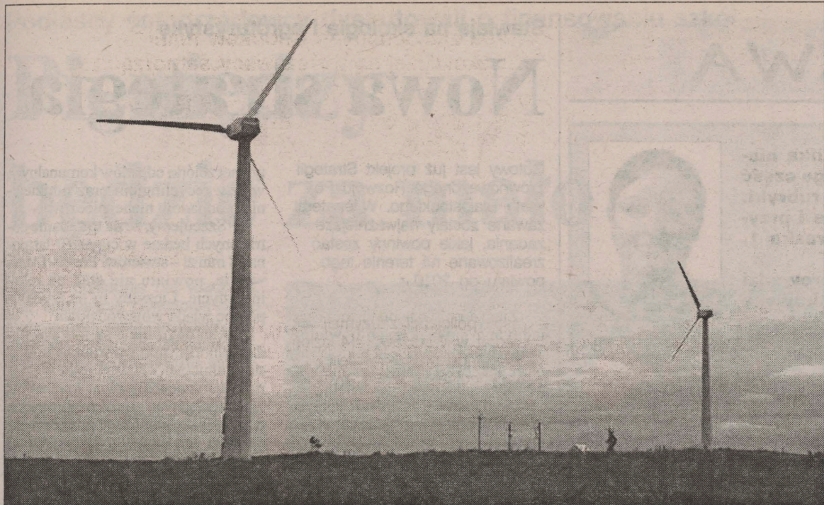
Dwa wiatraki o mocy 300 kW każdy, pracujące od sierpnia ub.r. na szczycie Góry Rowelskiej produkują ilość energii wystarczającą na potrzeby gminy Wiżajny
