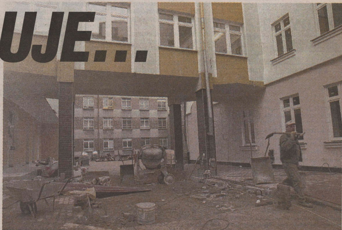
Decyzję o modernizacji szpitala przy ul. Warszawskiej podjęto w 1984 roku. Za inwestycję odpowiada obecnie Urząd Marszałkowski.
