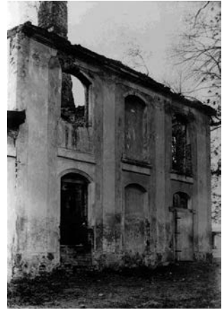
7. Jeden z pawilonów gościnnych po zniszczeniach wojennych. Fot. J. Glinka, lata trzydzieste XX w., TG One of the guest pavilions after wartime destruction. Photo by J. Glinka, 1930s, TG
