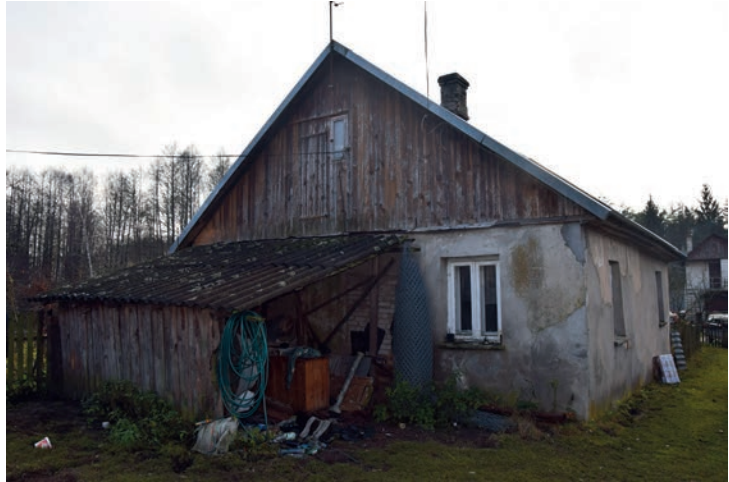
8. Płoskie nr 18 – widok na budynek z zewnątrz. Fot. D. Dakowicz, 2019 Płoskie No. 18 – view of the building from the outside. Photo by D. Dakowicz, 2019
