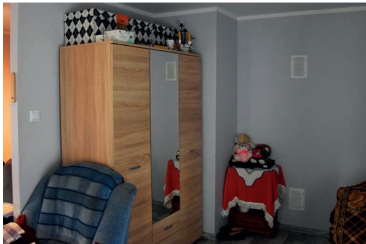
7. Widok na komin i ściankę działową zastępującą ścianówkę.
