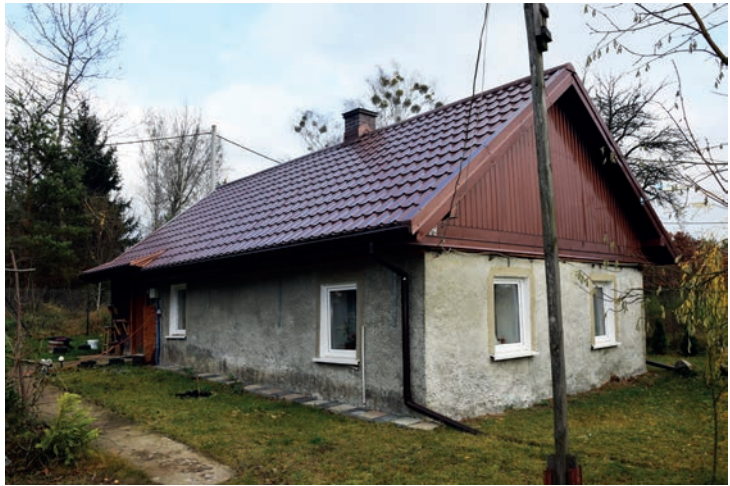
2. Płoskie nr 19 – widok na budynek z zewnątrz. Fot. D. Dakowicz, 2019 Płoskie No. 19 – view of the building from the outside. Photo by D. Dakowicz, 2019
