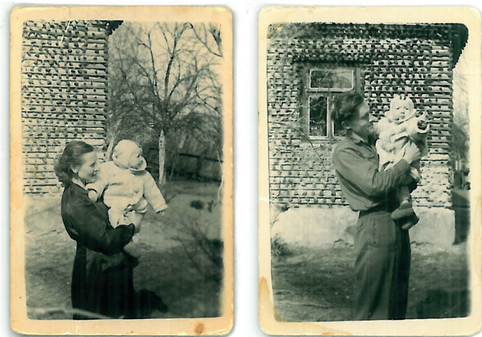
13. Widoki na nieotynkowane ściany budynku. Fot. z archiwum właścicieli, lata 1956–1957 Views of the unplastered building. Photo from the owners' archive, 1956–1957
