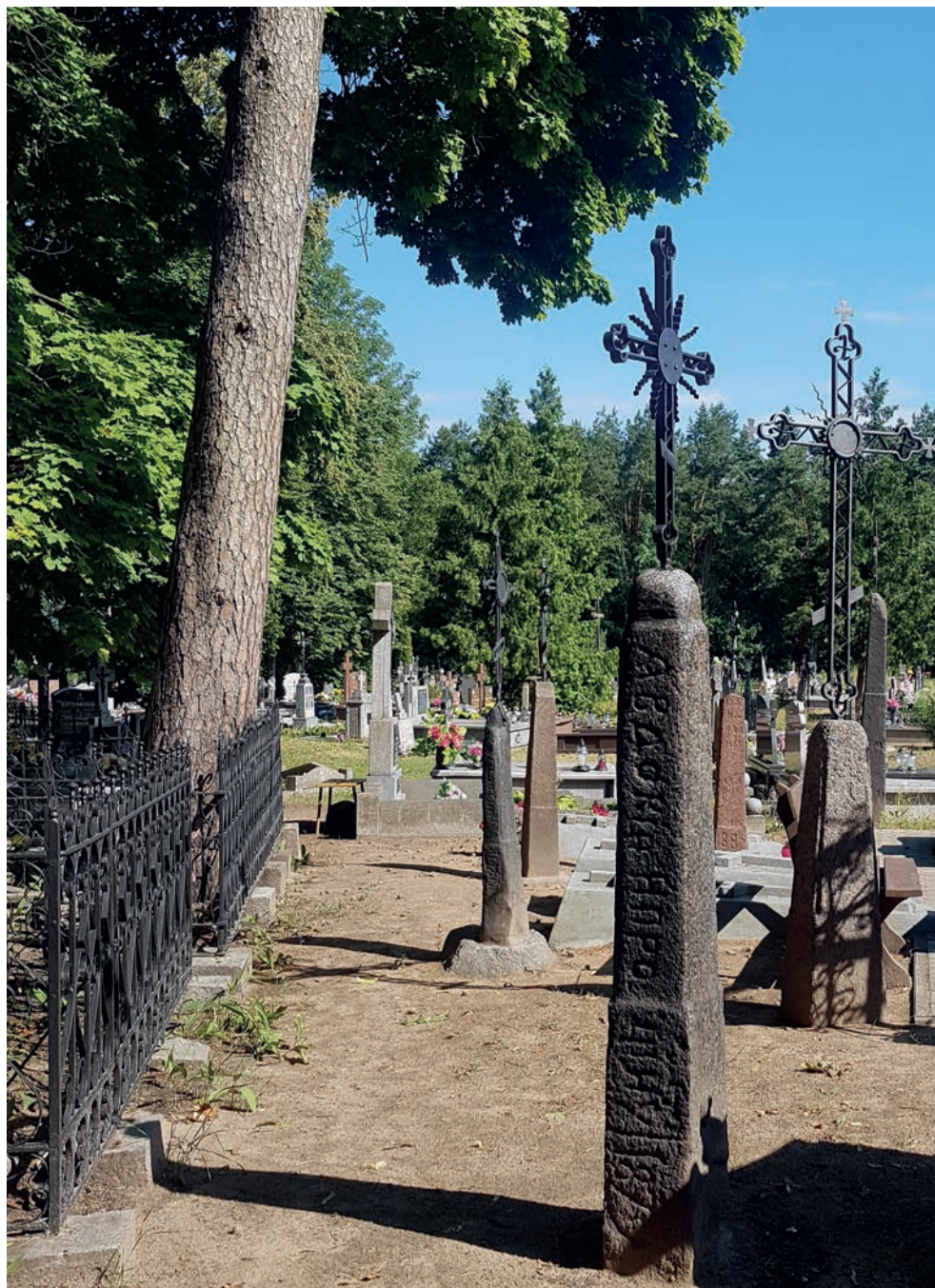
17. Kamienne nagrobki zwieńczone kutymi krzyżami z lat siedemdziesiątych XIX w. na cmentarzu w Szczytach-Dzięciółowie – stan po konserwacji. Fot. W. Konończuk Stone gravestones topped with wrought iron crosses from the 1870s in the cemetery in Szczytach-Dzięciółowo – state after conservation. Photo: W. Konończuk
