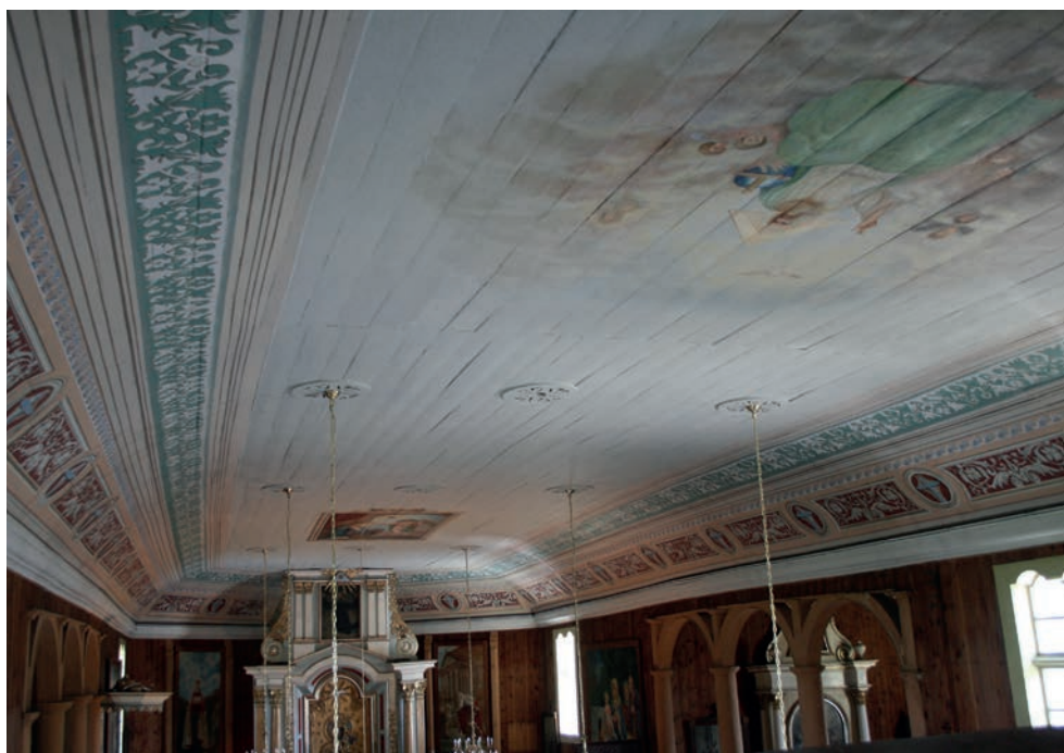
15, 16. Turośl. Kościół pw. św. Jana Chrzciciela. Polichromia po konserwacji, 2018. Fot. M. Andron Turośl. Church of St. John the Baptist. Polychrome after conservation, 2018. Photo: M. Andron
