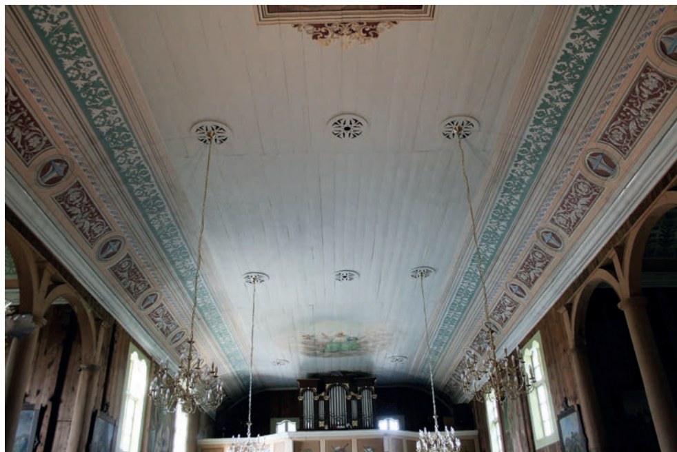
14. Turośl. Kościół pw. św. Jana Chrzciciela. Polichromia po konserwacji, 2018. Fot. M. Andron Turośl. Church of St. John the Baptist. Polychrome after conservation, 2018. Photo: M. Andron
