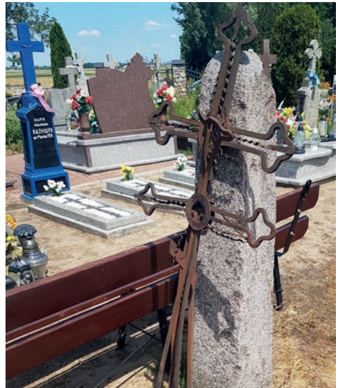
38. Cokół kamienny z uszkodzonym krzyżem na cmentarzu w Starym Korninie. Fot. W. Konończuk Stone pedestal with a damaged cross in the cemetery in Stary Kornin. Photo: W. Konończuk
