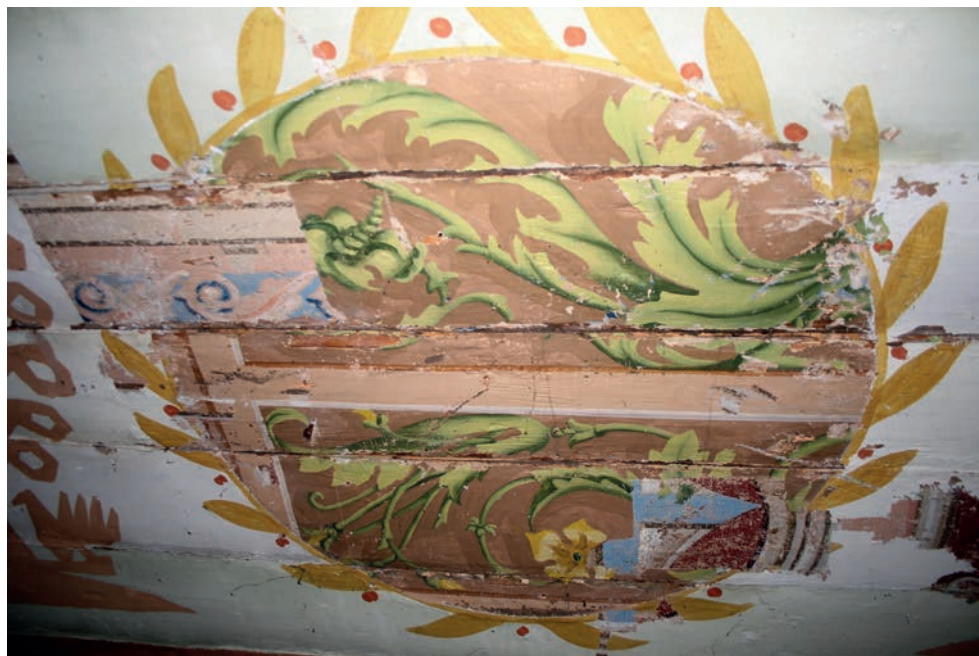
9. Turośl. Kościół pw. św. Jana Chrzciciela. Polichromia stropu, czwarta warstwa chronologiczna znajdująca się pod warstwą z 1971 r., 2015. Fot. M. Andron Turośl. Church of St. John the Baptist. Ceiling polychrome, fourth chronological layer beneath a layer from 1971, 2015. Photo: M. Andron
