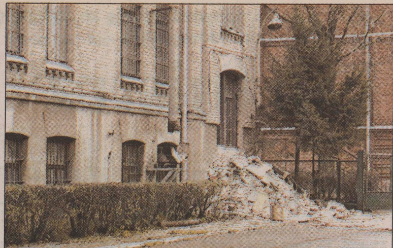
Prace adaptacyjne w budynku przy ul. Legionowej mają zakończyć się w lipcu
