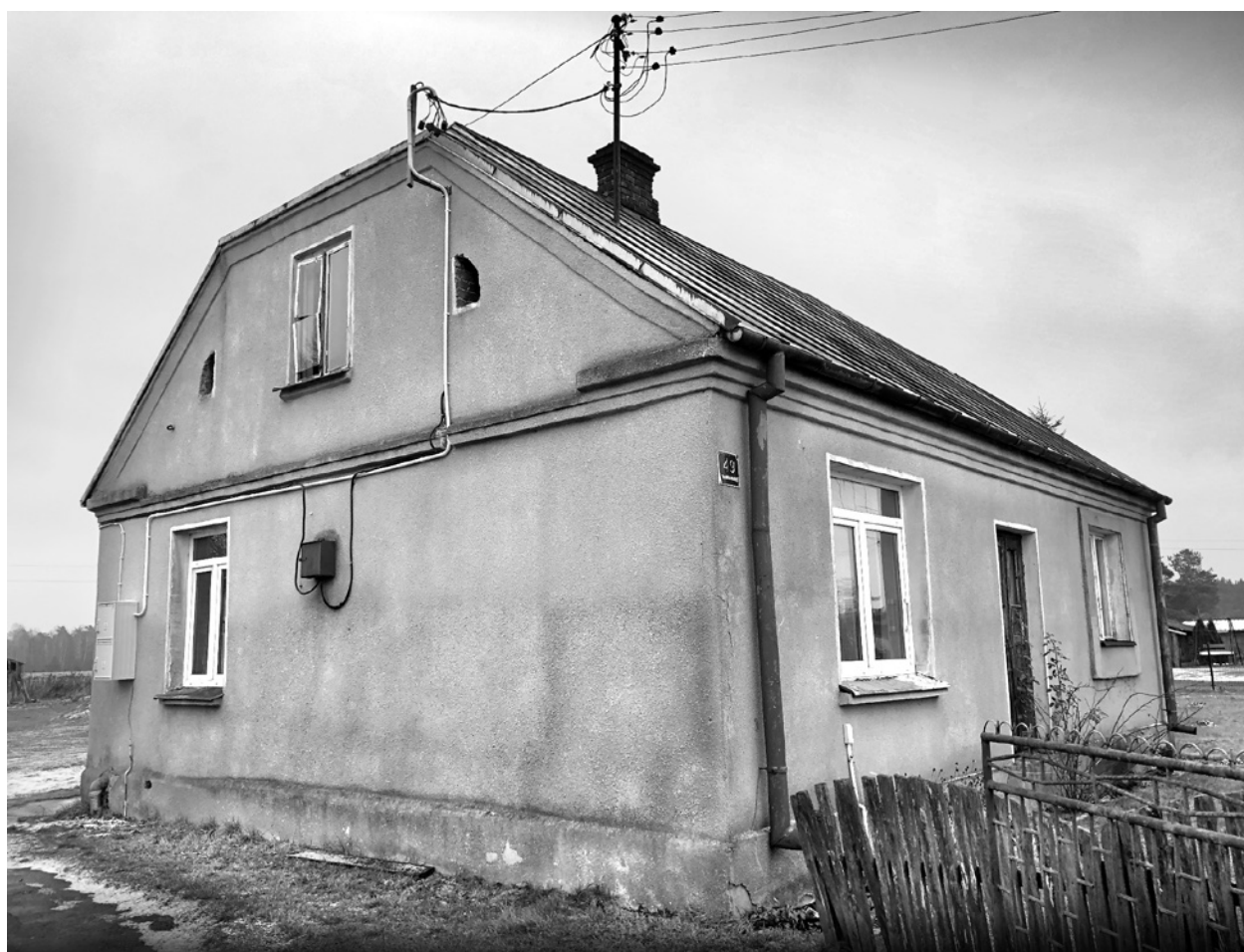
Ryc. 3. Żużlobetonowy dom w Durlasach (nr 49); fot. autorka
