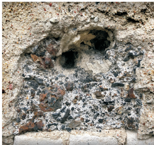
Ryc. 2. Odkrywka konstrukcji żużlobetonowej ściany domu nr 62 w Durlasach; fot. N. Mąka
