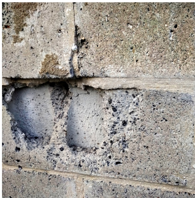
Ryc. 7. Budynek inwentarski z pustaków żużlobetonowych w Piętkach-Gręzkach – fragment ściany; fot. autorka Fig. 7. The old cowhouse in Piętki-Gręzki – a wall detail; source: the author
