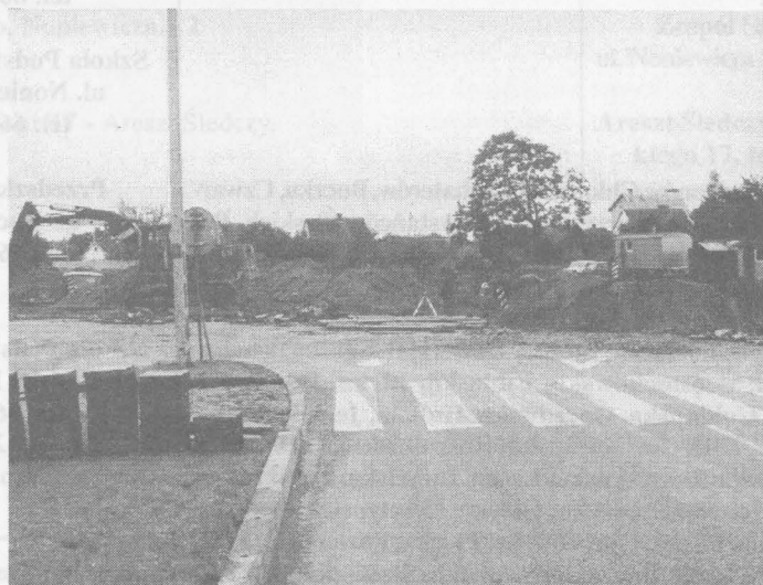
Roboty drogowe między ulicami Reja i Szpitalną.
