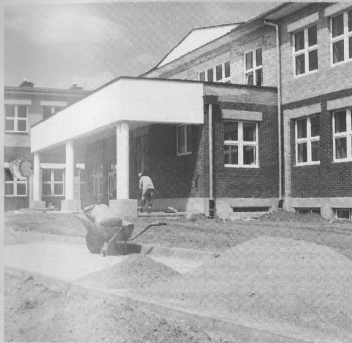
Szkola Podstawowa nr 11 (w budowie).
