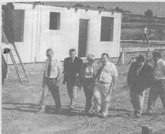
Minister Barbara Blida wizytuje plac budowy.
