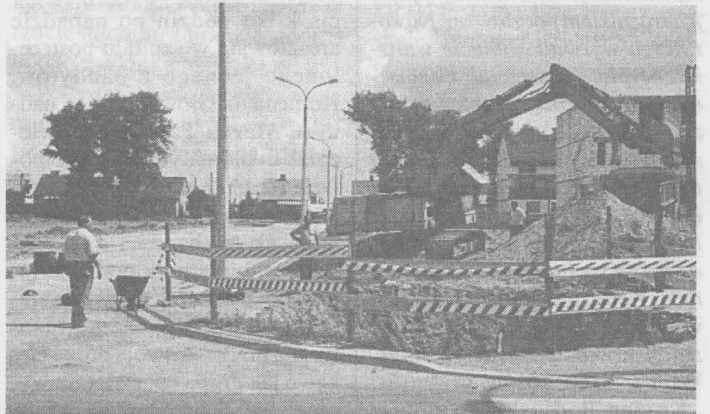
Na ulicy Brzostowskiego wykonywane są kanalizacje wodociągowa, deszczowa i sanitarna, a także nawierzchnia chodnikowa. Zakończenie prac przewiduje się na 30 października br. Fot. Z. Gałaszewski
