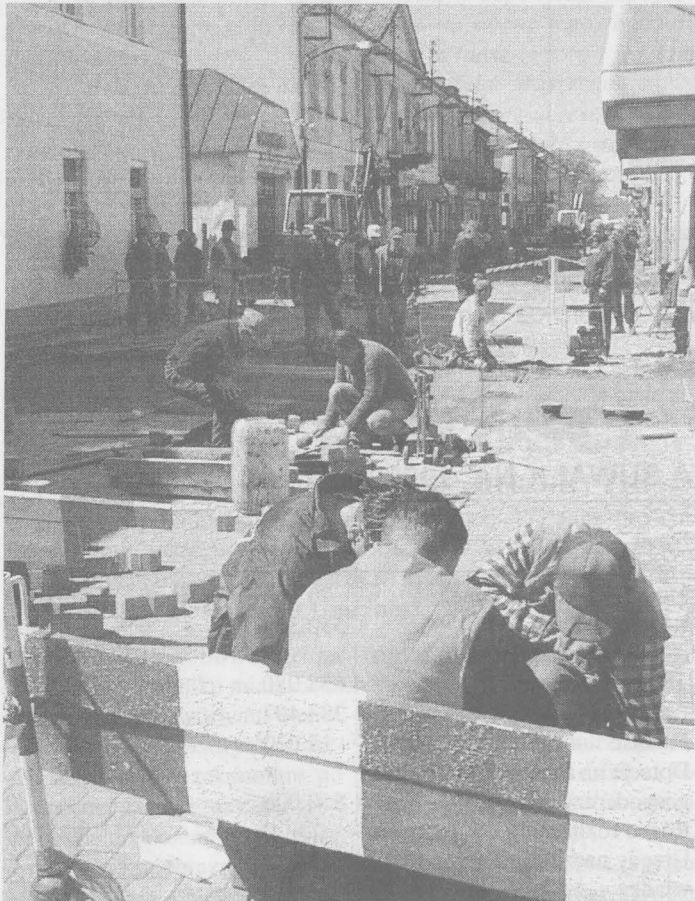
Modernizacja ul. Chłodnej.
