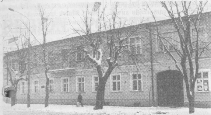
Budynek przy ul. Kościuszki 36, dawna siedziba Szkoły Handlowej i Muzeum Ziemi Suwalskiej. Fot. W. Arasimowicz.
