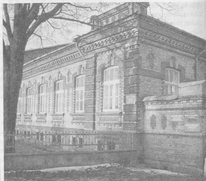
Mimo starych szyldów jest to już geodezja miejska.
