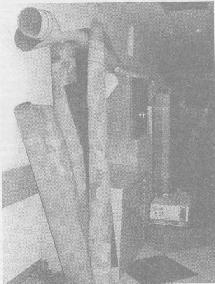
Na parterze byłego Urzędu Wojewódzkiego trwa remont.
