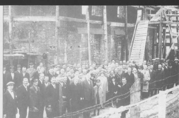
Budowa Elektrowni Miejskiej przy ul. Sejeńskiej, ok. 1930 r.
