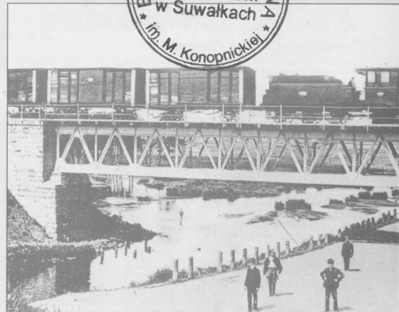
Most kolejowy na Czarnej Hańcy ok. 1905 r.
