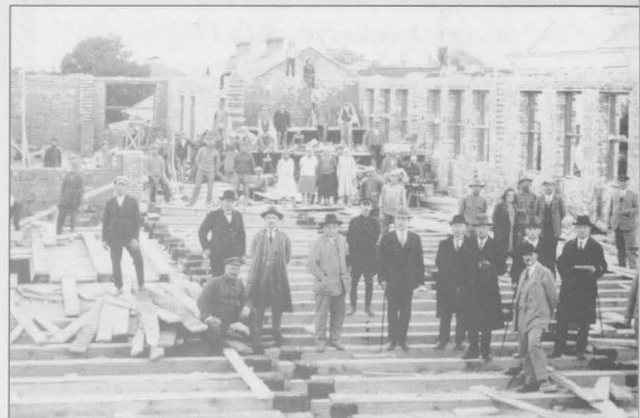
Budowa Szkoły Powszechnej nr 1 i 2, rok 1930.
