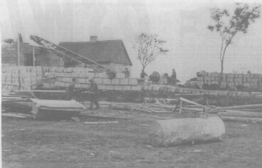
Tak wyglądał plac budowy.
