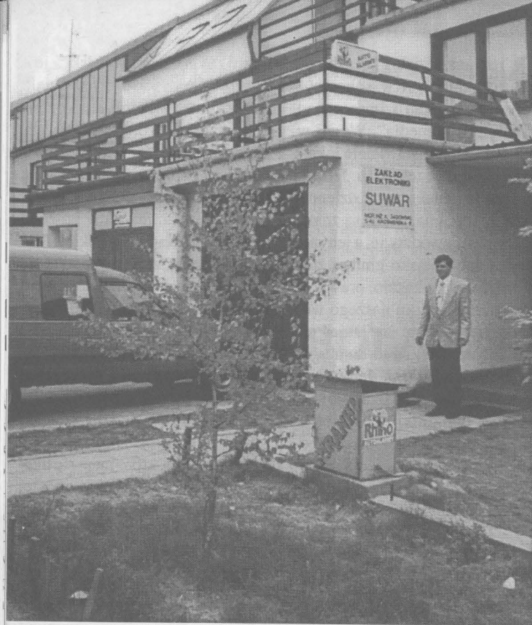
Widok na budynek zakładu przy ul. Krośnieńskiej 6.
