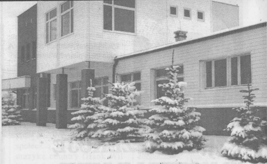
Budynek dyspozytorni i laboratorium oczyszczalni ścieków.
