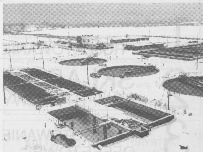
Widok ogólny na oczyszczalnię ścieków.
