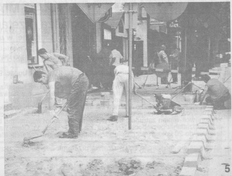
Trwają prace przy układaniu nowego chodnika na ul. Noniewicza.
