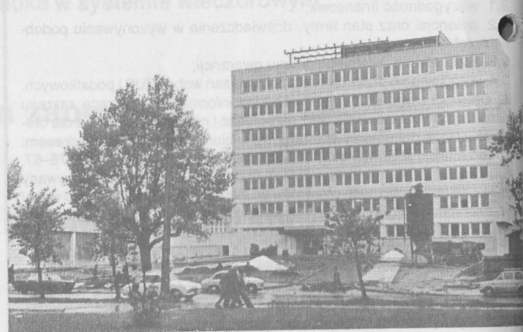
Na zdjęciu: Meta etapu (w budowie) przy ulicy Noniewiczza (1981 r.).
