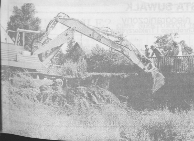
Rozpoczęła się budowa nowego mostu przy ul. Utrata.
