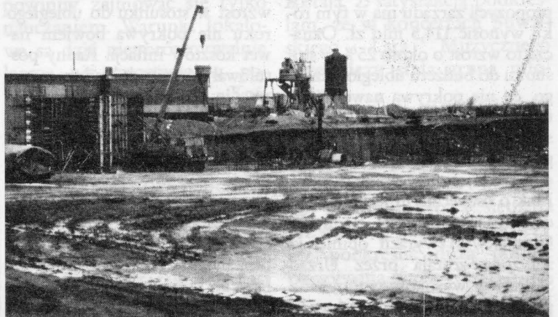
Teren budowy III stopnia oczyszczalni.
