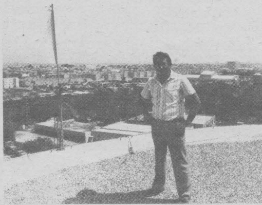
Marian Chmielewski na tle budowy osiedla Gurgi w Trypolisie.
