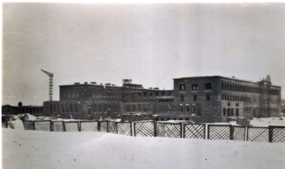
Budowa szpitala powiatowego w Bielsku Podlaskim, ok. 1959 r.
