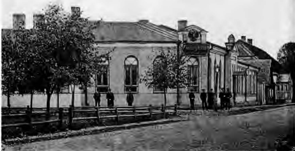
Urząd Skarbowy w Bielsku Podlaskim, około 1910 roku. Budynek zlokalizowany był naprzeciwko klasztoru pokarmelickiego. Obiekt celom skarbowym służył także w okresie międzywojennym. Według Stanisława Millera został wysadzony w powietrze przez odступа- jące oddziały Armii Czerwonej w czerwcu 1941 roku
