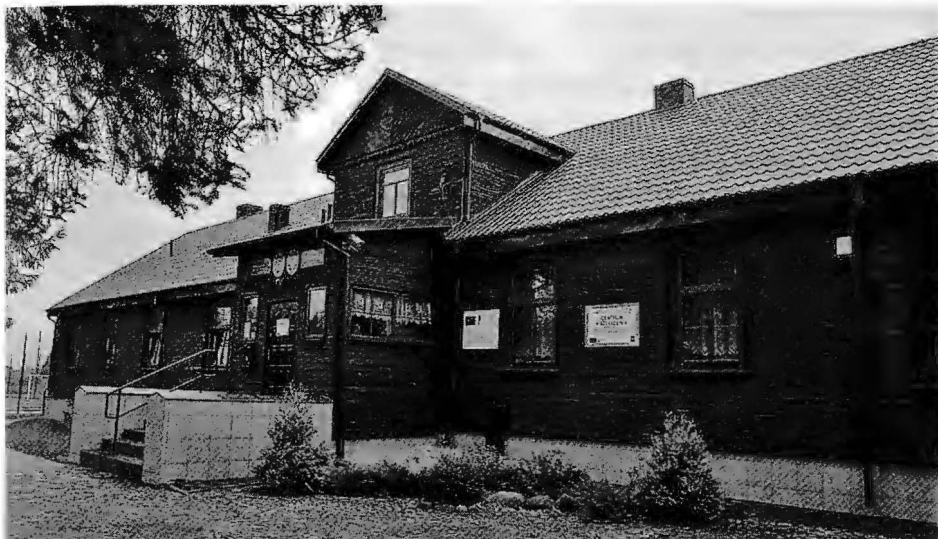
Dwór Węgierskich w Kalnicy, zniekształcony przebudową i remontami
